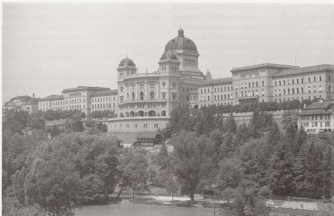
26. Bern, Bundeshaus. Links der Altbau von 1852–1857, rechts und in der Mitte Verwaltungs- und Parlamentstrakt von Hans Wilhelm Auer, der erste erb. 1888–1892, der zweite 1894–1902
