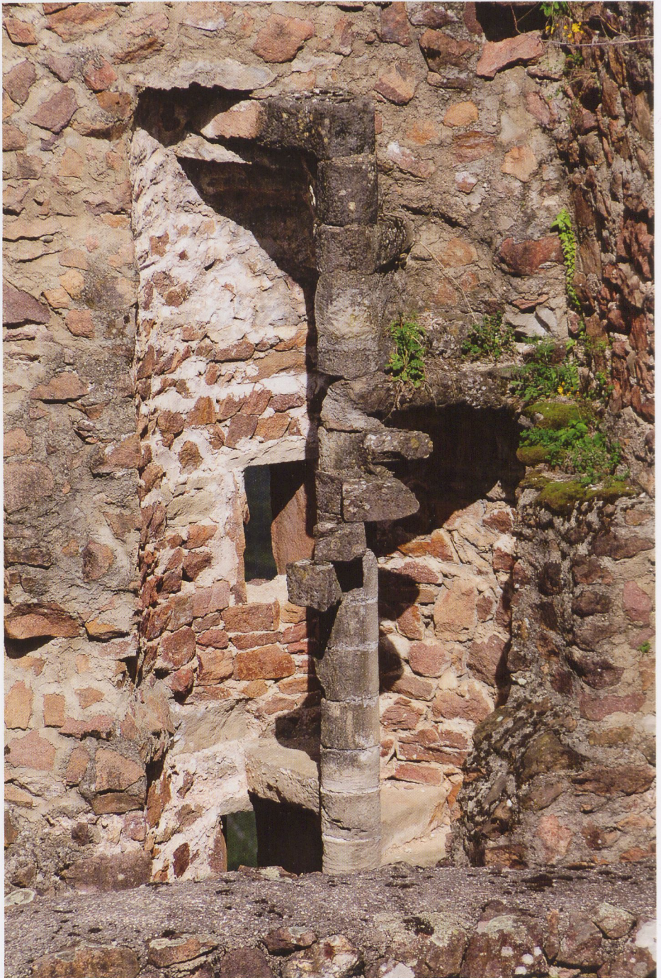
Abb. 19 Boymont, die Reste der Wendeltreppe, die von der Kapelle in die beiden Geschosse darüber führt (2009). Die beiden Lichtschlitze sieht man auf Abb. 20 von außen.
