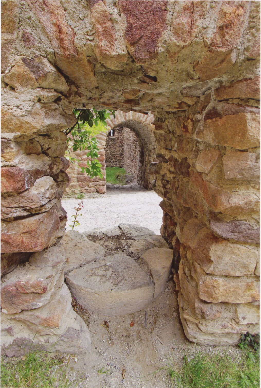
Abb. 33: Boymont, der Stumpf einer Rundstütze in der Hofwand des Korb'schen Hauses, von Norden gesehen. Die Höhe des Loches deutet an, wie hoch der Stumpf noch war, als man ihn in die Mauer einbezog; hinten der Zugang zum Erdgeschoss des Palas.
