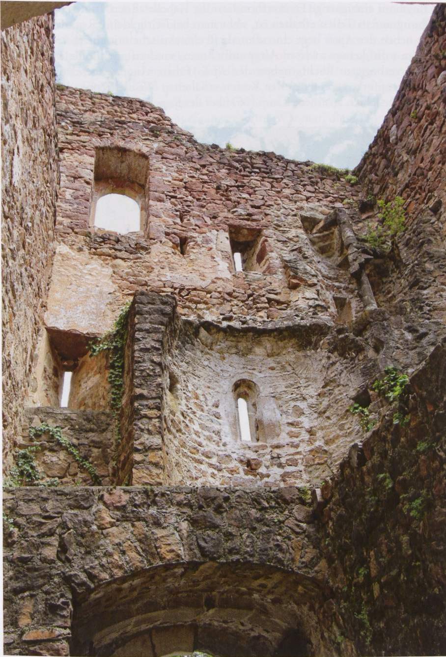
Abb. 18 Boymont, Blick aus der heute deckenlosen Torhalle auf die Ostpartie der Kapelle im 1. Obergeschoss und die Fenster im ehemaligen Geschoss darüber. Sichtbar sind die ehemals halbkuppelgewölbte Apsis der Kapelle und die ehemals ummauerte Wendeltreppe rechts, die von der Kapelle ins Geschoss darüber und auf die Wehrgänge bzw. Dächer führte.
