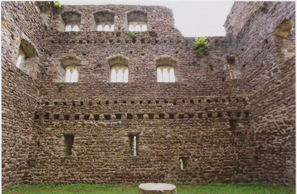
Abb. 22: Boymont, die Südwand des Palas von innen; vgl. dazu Abb. 21. Ungewöhnlich ist die doppelte Balkenlochreihe über dem Erdgeschoss, die auf eine (beheizbare?) Hohldecke deutet.
