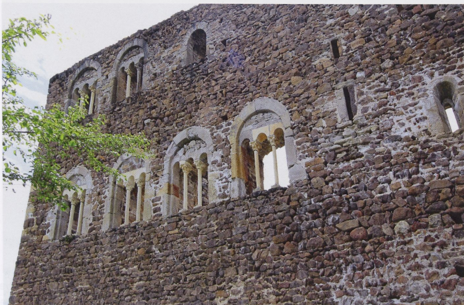
Abb. 20 Boymont, die beiden Triforienreihen des Palas in der Ostfront der Burg; von den Säulen ist hier nur eine einzige noch alt (obere Fensterreihe ganz rechts). Ganz rechts das Fenster der Kapellenapsis, daneben die beiden Lichtschlitze der Wendeltreppe
