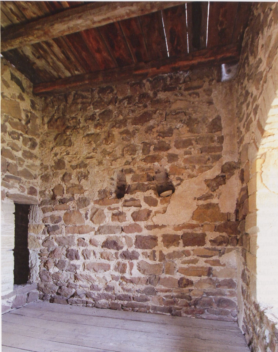
Abb. 12 Boymont, das Einstiegsgeschoss (Raum 24) des Hauptturmes, die Nordwand mit den Öffnungen der beiden schräg abwärts führenden Kanäle, in denen längs durchbohrte Rundhölzer („Rohre“, vgl. Abb. 13) eingemauert waren. Links der Abortzugang (vgl. Abb. 8), rechts die Nische der östlichen Triforie.
