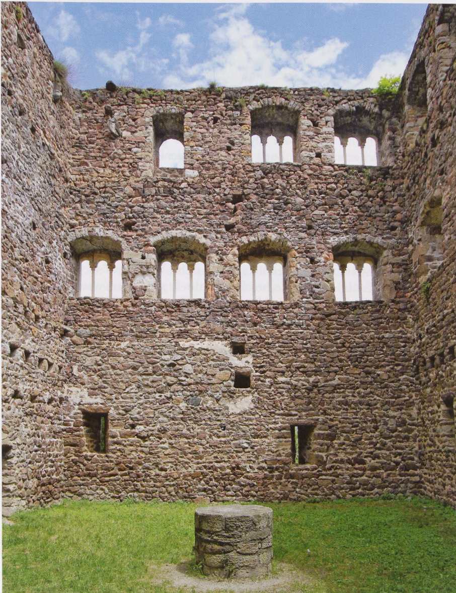
Abb. 23 Boymont, die Ostwand des Palas von innen; vgl. dazu Abb. 20. Die unterschiedliche Höhenlage der beiden Lichtschlitze im Erdgeschoss ist auf das leichte natürliche Gefälle nach rechts/Süden zurückzuführen; der heutige ebene Boden entstand erst später durch Auffüllung. Die Löcher für zwei Mittelunterzüge übereinander bestätigen die Hohldecke. Ganz oben links die Reste der Haube eines Eckkamins.
