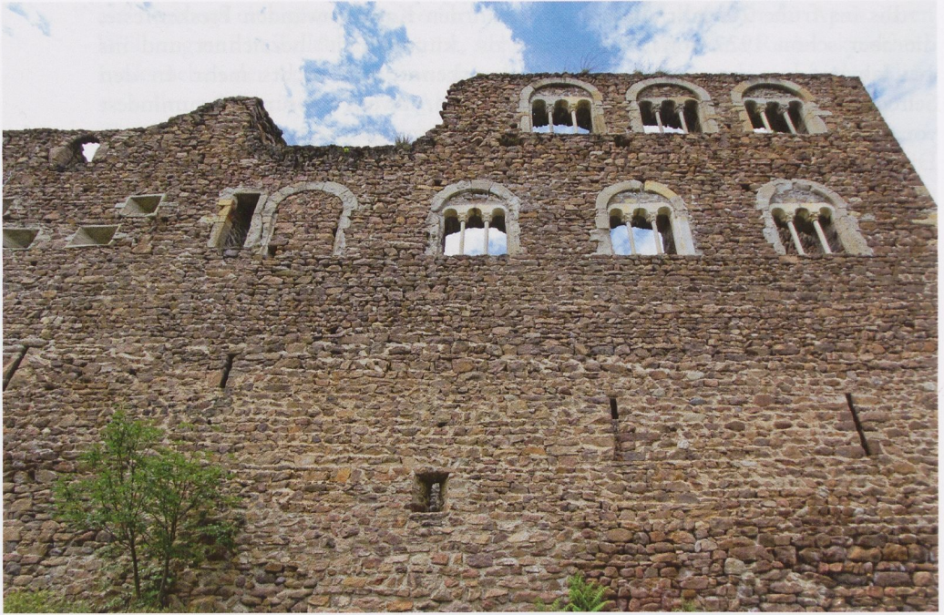
Abb. 21: Boymont, die Südwand des Palas von außen. In der oberen Triforienreihe sind noch vier Säulen alt, in der unteren wurde das Triforium ganz links möglicherweise schon beim Bau der Burg aufgegeben, wegen der eng daneben angeordneten Abortpforte. Unten drei originale Lichtschlitze des Erdgeschosses (und eine neue Öffnung in einem vermauerten Ausbruch). Über den drei Schlitzen ist eine schräg nach links oben verlaufende Baunaht zu erkennen, die Krone der zunächst nur bis in diese Höhe ausgeführten Ringmauer.
