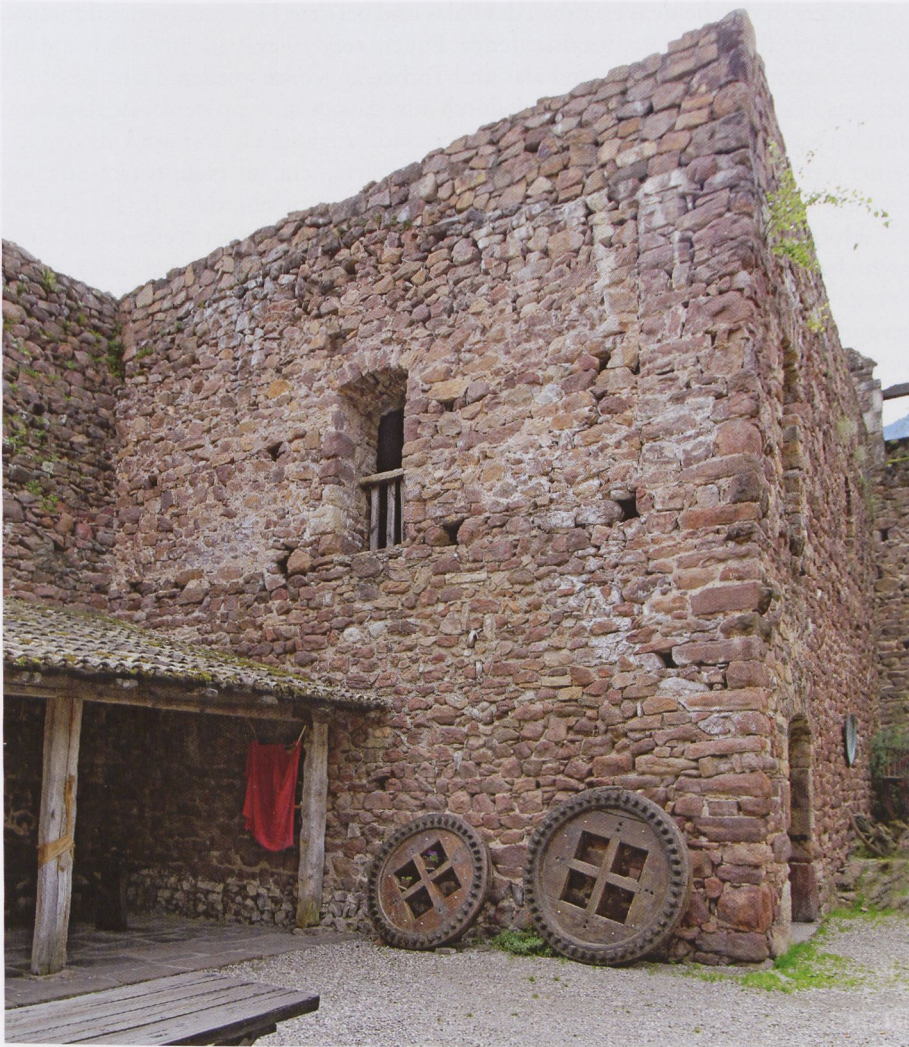
Abb. 35 Boymont, die Ostwand des Hauses in der Südwestecke gegen Westen; die Buckelquader an der Ecke unterstreichen die Gleichzeitigkeit mit den beiden Türmen der Burg. Deutlich sichtbar ist die Fuge, die im Obergeschoss die Nordwand (rechts) von der Ostwand trennt. Der Bau war hier ursprünglich offen oder eher durch eine Holzwand abgeschlossen, die erst später durch Mauerwerk ersetzt wurde.
