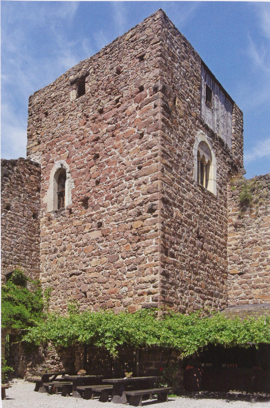
Abb. 16 Boymont, der Nordwestturm vom Hof. Das viel schlechtere Mauerwerk des obersten Geschosses ist deutlich erkennbar, die dort teilweise nur verbretterte Ostwand entstand erst in den 1970er Jahren.
