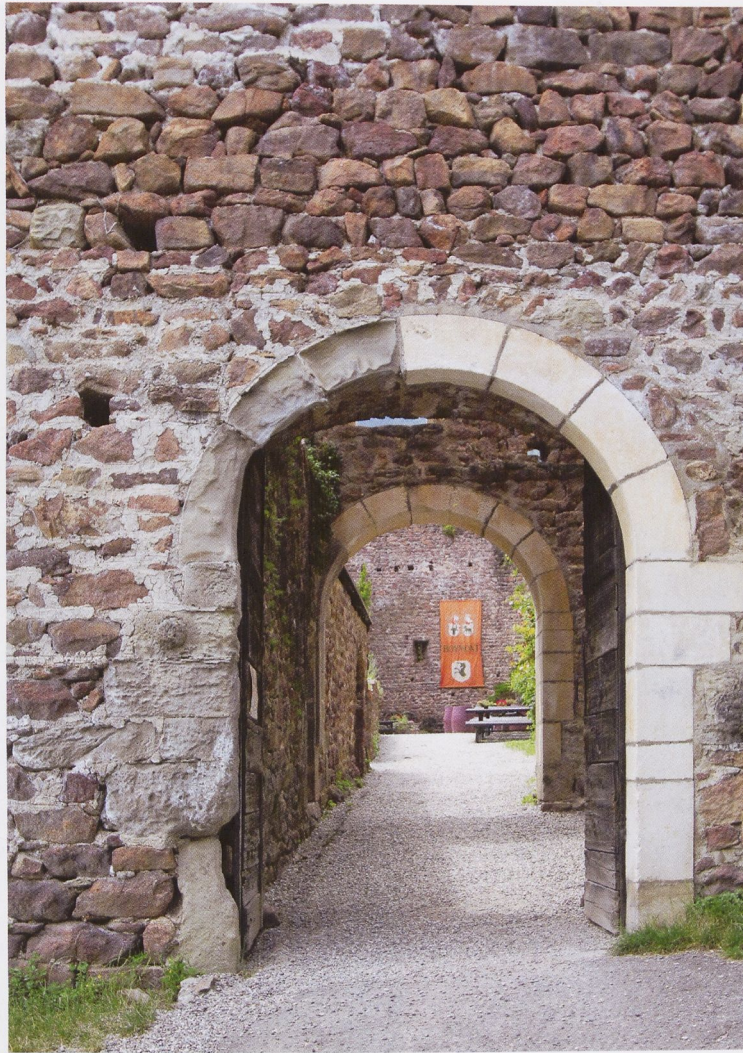
Abb. 6 Boymont, das Tor von außen (2014). Deutlich ist die fortgeschrittene Verwitterung der alten Gewändesteine aus Sandstein gegenüber den rechts bei einer Restaurierung neu eingefügten Steinen. Es sind noch zwei Buckelquader erhalten, links kugelförmig. Auf den hellen Verputzresten sind teils noch die originalen Ritzfugen erkennbar.
