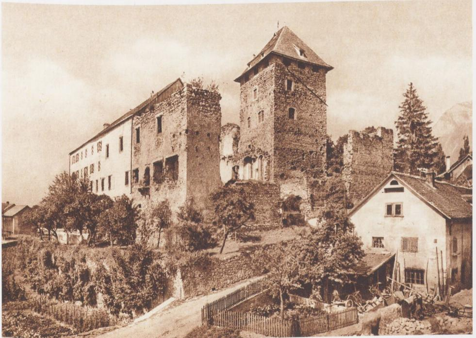
**Abb. 1:** Maienfeld, die Burg von Südosten. Oben um 1900, mit dem hinter den Zinnen kaum erkennbaren Flachdach des Turmes (und den Fenstern der Wohnung in den obersten Geschossen), unten 1936 mit dem Zeltdach von 1906. Vorne der zerstörte Teil des „Neuen Schlosses“ mit den hofsseitigen Kapellenfenstern. (oben: Ansichtskarte; unten: Die Burgen und Schlösser der Schweiz, Lieferung 15, Graubünden I. Basel 1940, S. 13).
