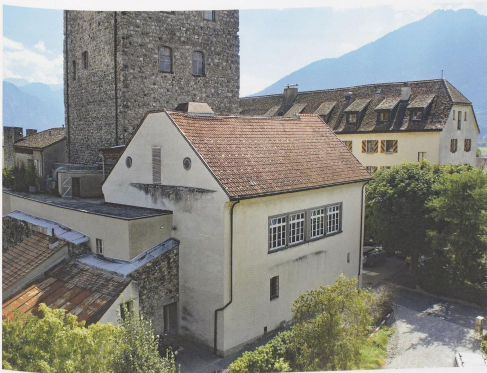
**Abb. 15:** Maienfeld, der vor 1984 errichtete Bau in der Nordecke der Burg. Seine gegen Nordwesten gerichtete Wand (rechts) sitzt auf einem schwach geknickten Rest der Ringmauer, dessen Oberkante durch die horizontale Schmutzspur unter dem Fensterband erkennbar ist.
