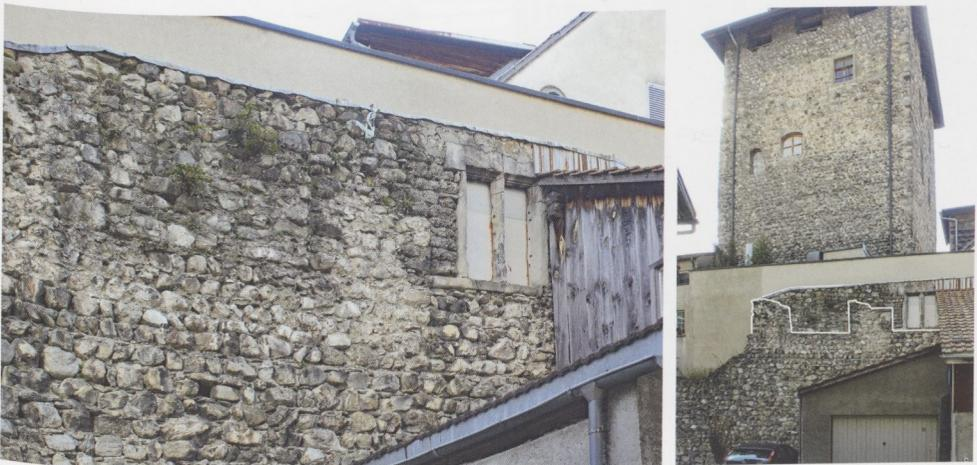
Abb. 20: Maienfeld, der ältere Mauerzug nordöstlich vor dem Turm besitzt vermauerte Zinnen (links); rechts sind ihre Umrisse weiss markiert. Das zweilichtige Rechteckfenster des 15. oder frühen 16. Jahrhunderts (vgl. Abb. 21) wurde sekundär in die westliche (rechte) Zinnenlücke eingesetzt.
