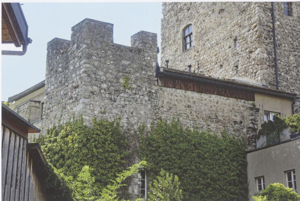
**Abb. 16:** Maienfeld, die Nordostecke der Ringmauer, oberer Teil von Nordosten; der untere Teil ist heute von dichtem Bewuchs verdeckt. Am rechten Ende des Mauerstücks springt ein abgebrochenes Mauerstück rechtwinklig vor, das belegt, dass die Mauer dort nicht einfach geradlinig weiterlief (vgl. Abb. 19).
