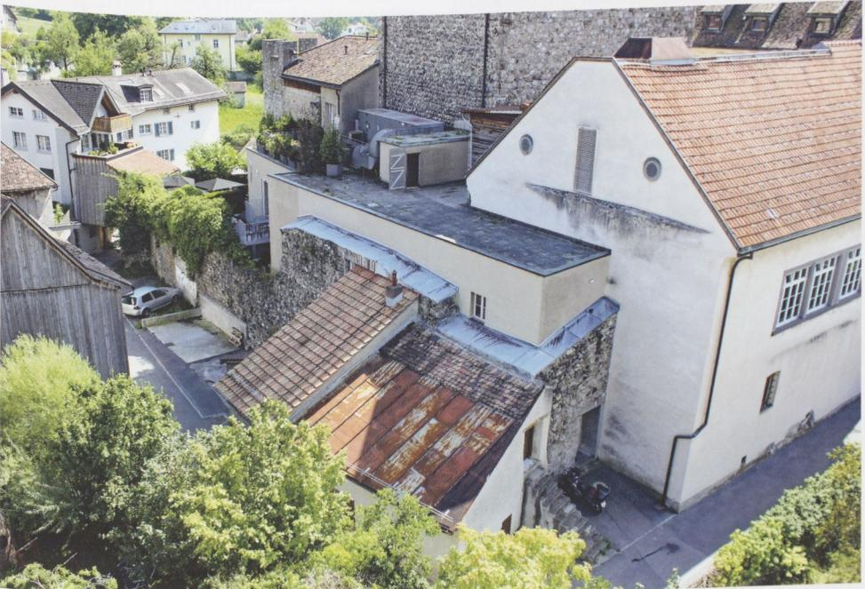
**Abb. 17:** Maienfeld, die Nordecke der Burg von Norden. Aus der Höhe ist die vor dem Turm und der östlichen Ringmauercke (links hinten, mit Eckerhöhung) vorbeiführende Zwingermauer gut zu erkennen, ebenso wie der moderne, längliche Küchenanbau, der vor dem Turm hinter der Zwingermauer eingefügt wurde.
