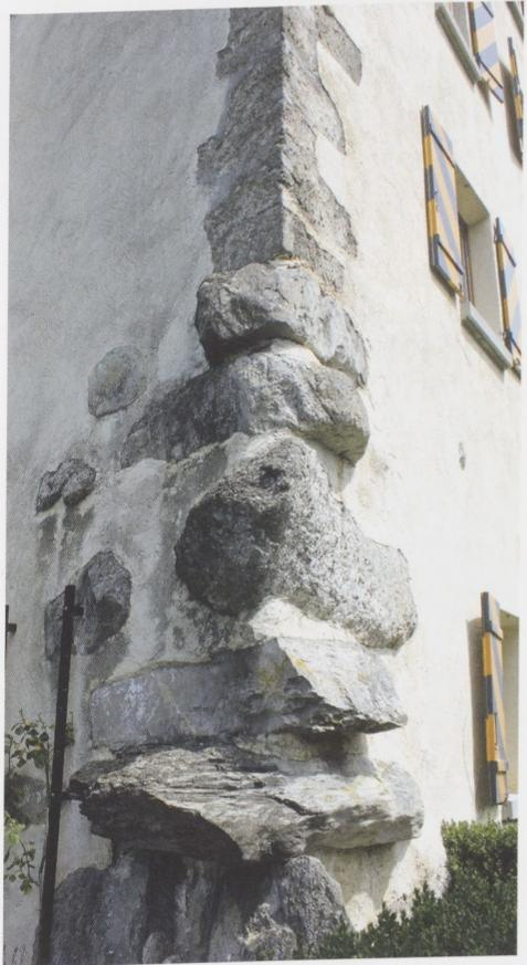
Abb. 24: Maienfeld, die wuchtigen Findlinge unter dem südlichen Eckverband gehören zu den wenigen Einzelheiten, die heute noch die spätmittelalterliche Entstehungszeit des „Neuen Schlosses“ äusserlich andeuten.
