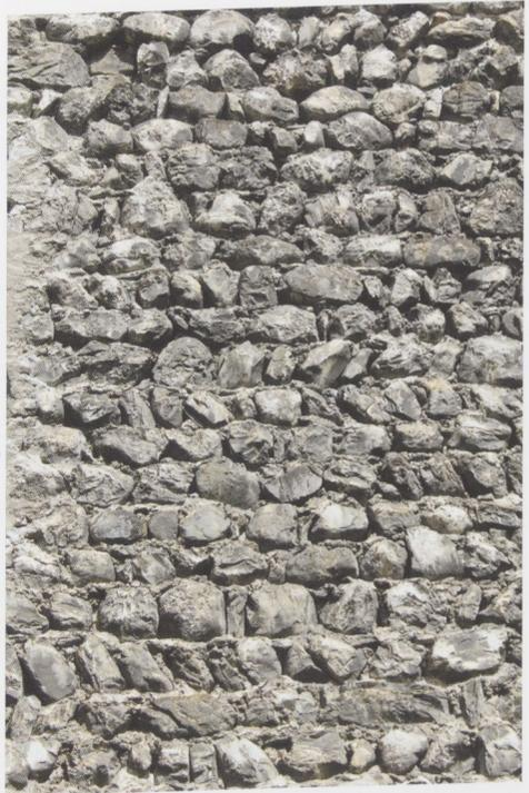
**Abb. 12:** Maienfeld, das Mauerwerk des Turmes an der unbauten Westseite besteht aus Flusskiesel und Bruchstein in sorgfältiger Schichtung; nur die Ecken zeigen grössere Steine mit Randschlag. Ein solches Mauerwerk gilt im Alpenraum weithin als „romanisch“, konnte aber bis ins 14. Jahrhundert vorkommen.
