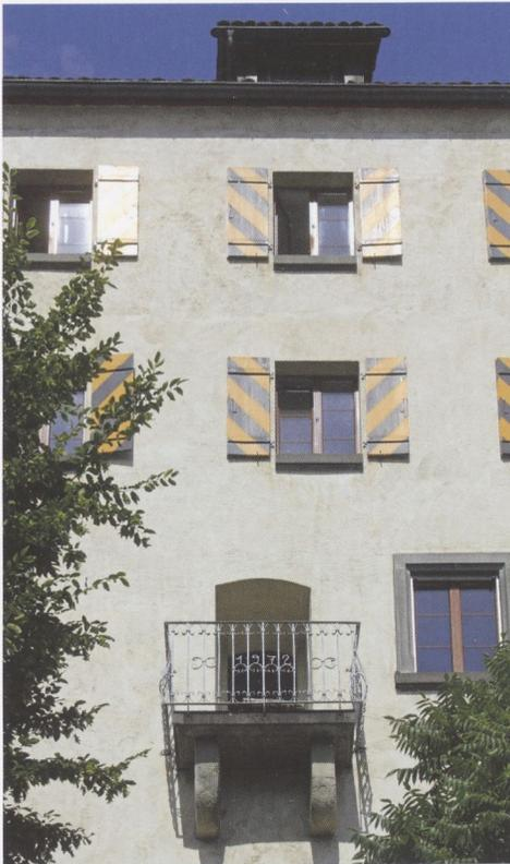
**Abb. 25:** Maienfeld, die Kragsteine unter dem modernen Balkon gehören zu den wenigen mittelalterlichen Details, die an der Südfassade des „Neuen Schlosses“ noch erhalten sind.
