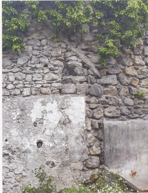
**Abb. 18:** Maienfeld, die Baufoqe im nordöstlichen Teil der Zwingermauer; rechts das ältere Mauerwerk (13. oder 14. Jahrhundert), links der Ansatz der Zwingermauer (15. Jahrhundert). Erkennbar ist ausserdem der Dachanschlag vom Ziegeldach eines neuzeitlichen Hauses oder Schuppens, von dem auch die ehemals weiss gestrichene Putzfläche links stammt.
