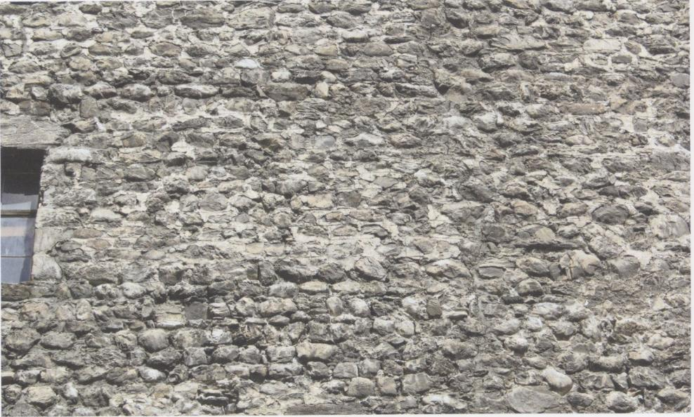
**Abb. 13:** Maienfeld, Reste von Fugenritzung an der Westwand des Turmes, auf Höhe des vierten Geschosses. Dieser Wandteil wurde ursprünglich durch eine Laube vor der Witterung geschützt.
