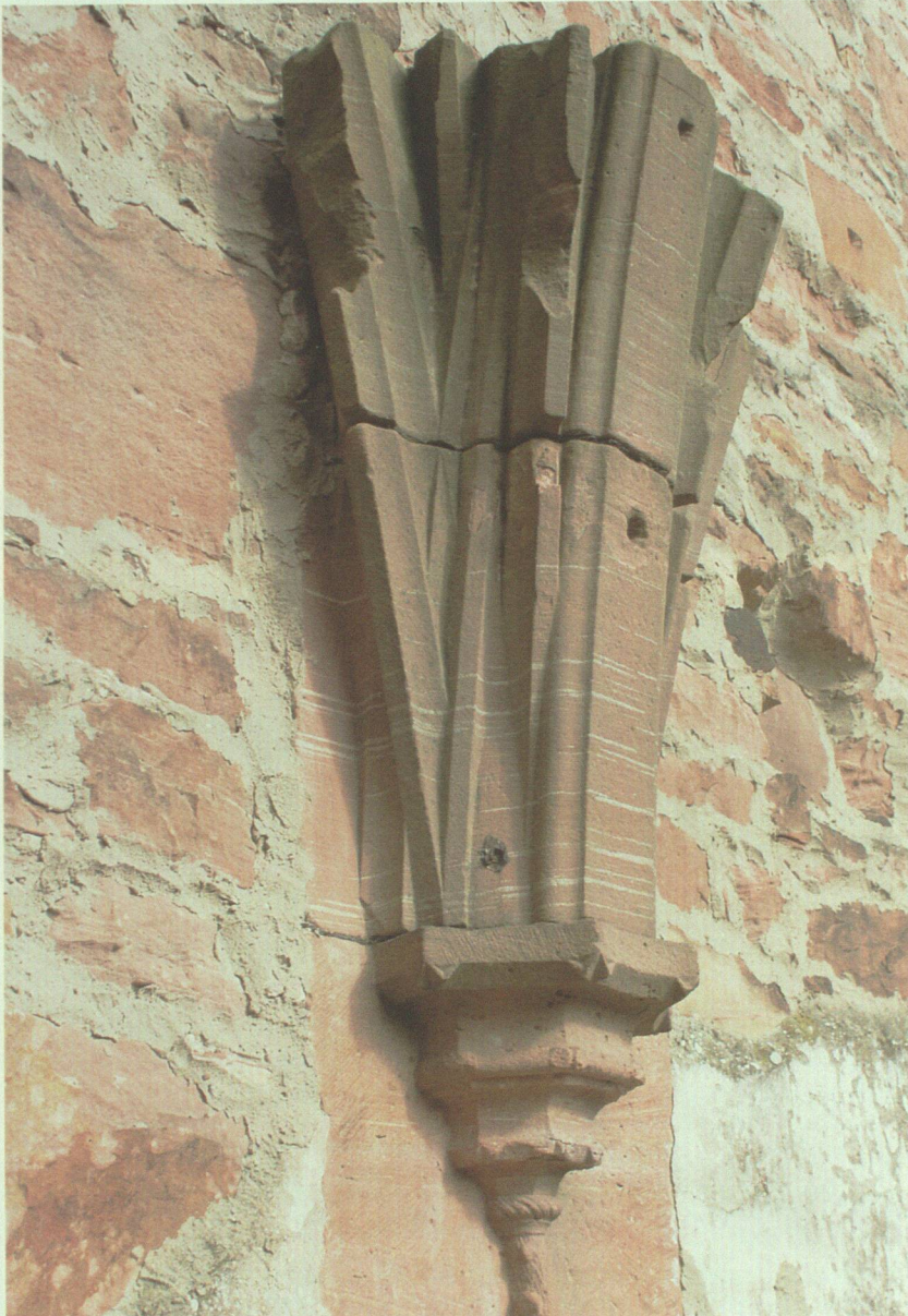
Abb. 8 Gewölbeanfänger in der Herrentafelstube
