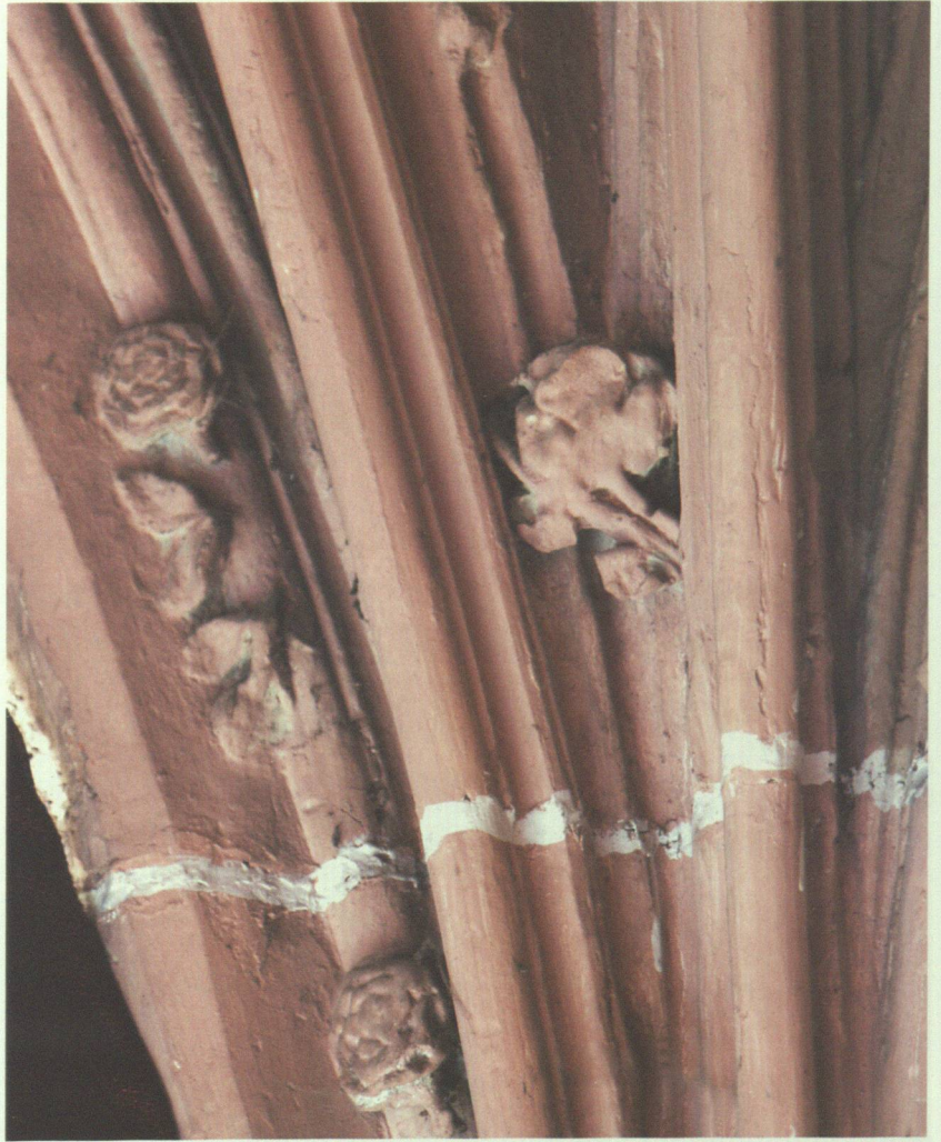
Abb. 5 Gewölbeanfänger im Norderker des Frauen- zimmerbaus, Nordostecke (Lorenz Lechler um 1515)
