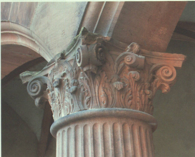
Abb. 4 Kapitel der Erdgeschoßarkade des Gläsernen Saalbaus (um 1546)
