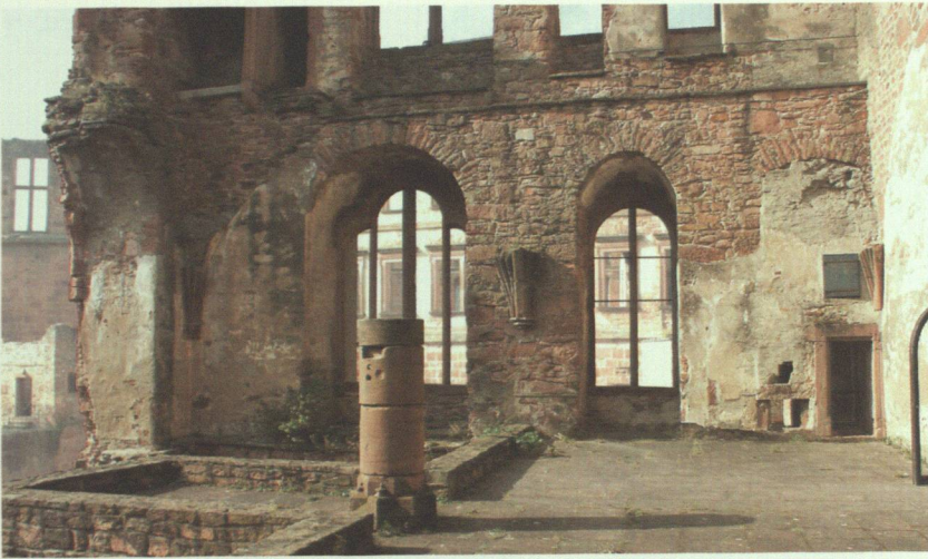
Abb. 7 Ruine der Herrentafelstube im sog. Bibliotheksbau, Blick nach Nordwesten (Lorenz Lechler um 1520). Rechts die Reste der für diesen Raumtypus konstitutiven Ofenanlage.
