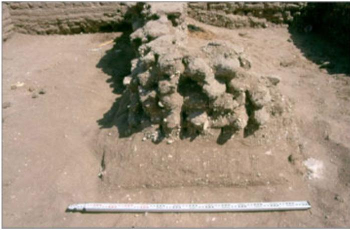
Abb.22 Von Wind und Wetter nach der Ausgrabung vor 90 Jahren erodierte Wand aus Lehmziegeln, Nordpalast.
