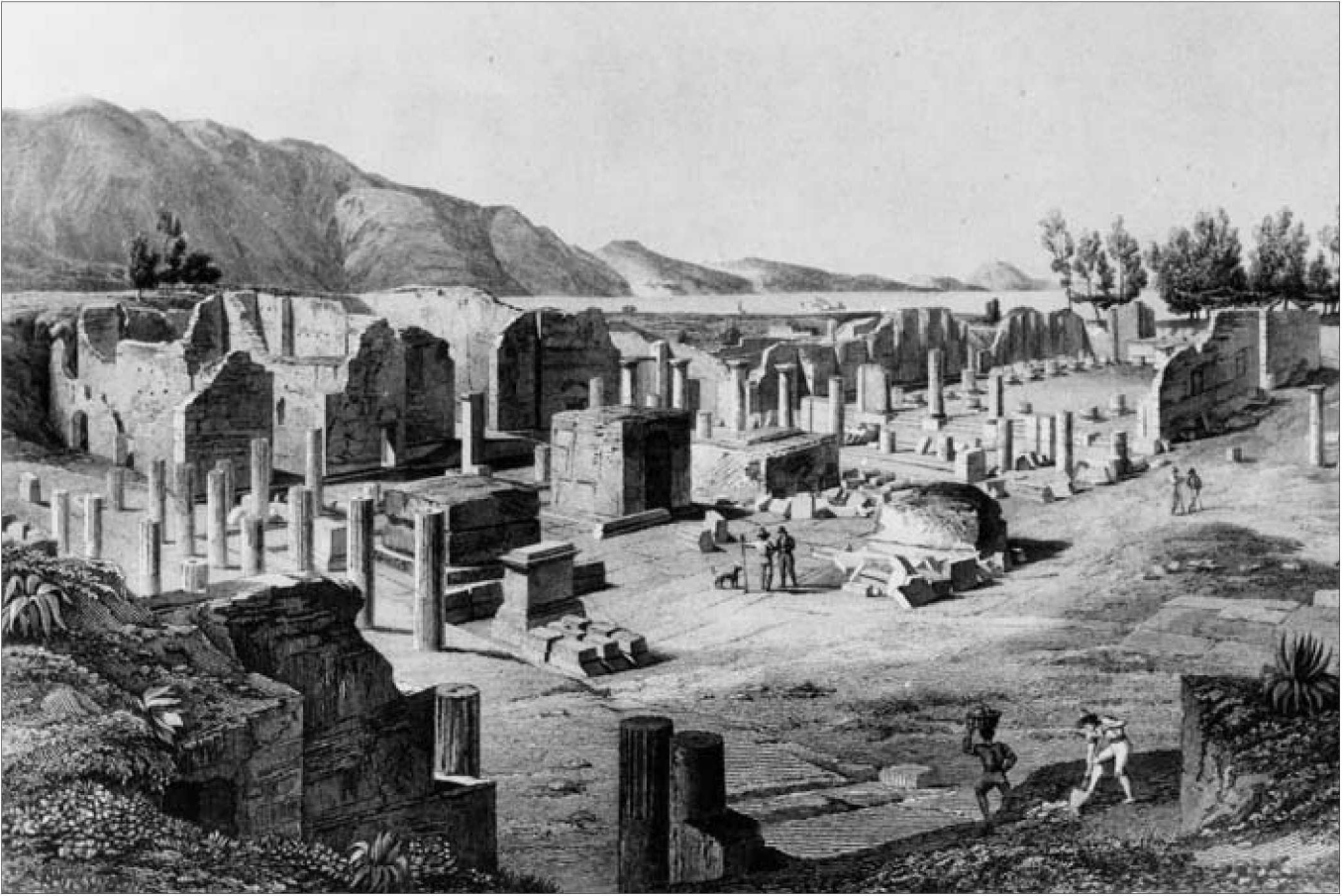
Abb. 1 François Mazois, Südteil des Forums von Pompeji um 1819
