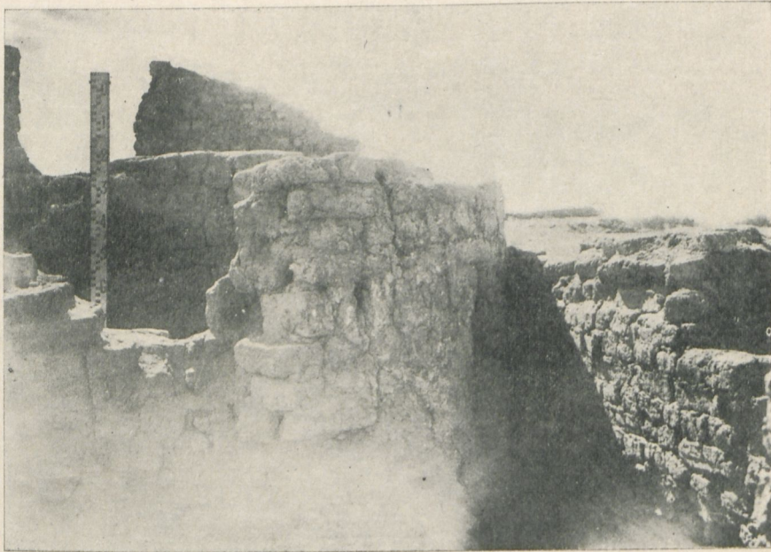
Fig. 89. — Le bastion romain n° 136; vue du Nord.
