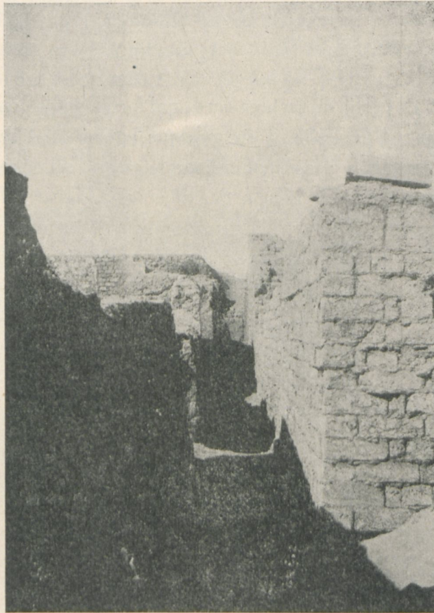
Fig. 63. — La ruelle \pi et la porte bouchée dans l'enceinte de la ville; vue de l'Est.
