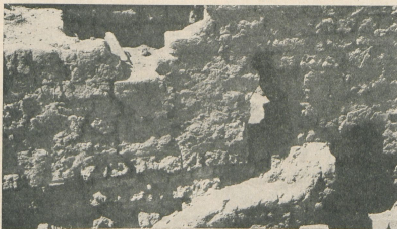
Fig. 71. — Niches dans le rempart ptolémaïque; vue de l'Est.
