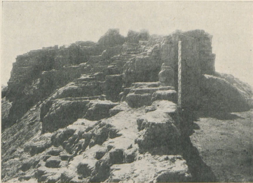
Fig. 85. — Les ruines à la pointe Nord du kôm; vue du Nord.
