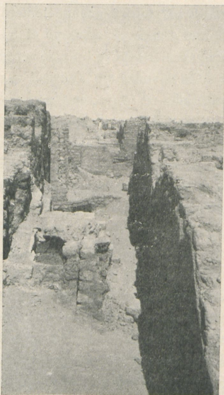
Fig. 69. — Chemin de ronde de l'époque romaine; vue du Sud.
