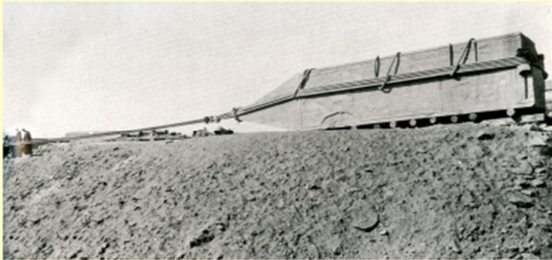
Moderner Transport eines Teils eines Obeliskens auf Rollen und Holzunterlage
