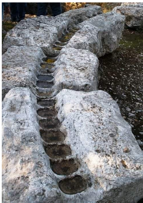
Εικ. 13_2: Εγκατάσταση πλύσεως μεταλλεύματος στα αρχαία ορυχεία Λαυρίου
