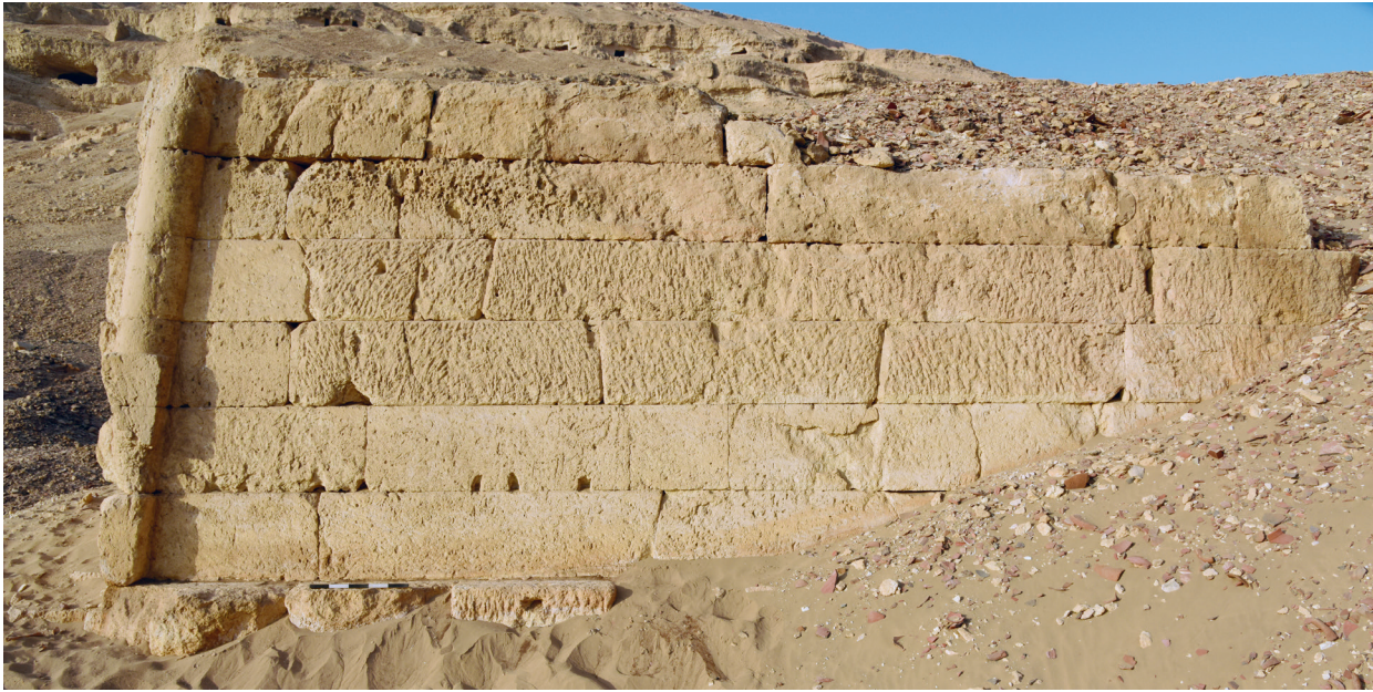
Abb. 26: Pylon, Südturm, Ostfassade
