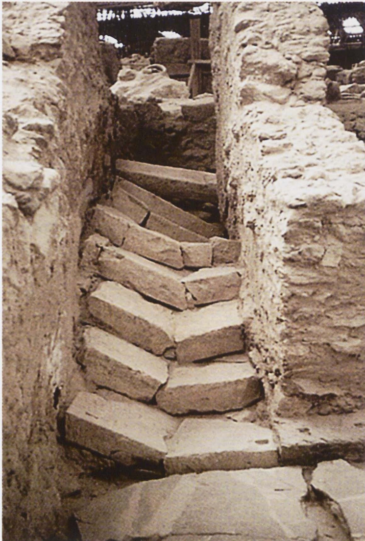
3 Treppe in Akrotiri, die vom Erdbeben beschädigt wurde
