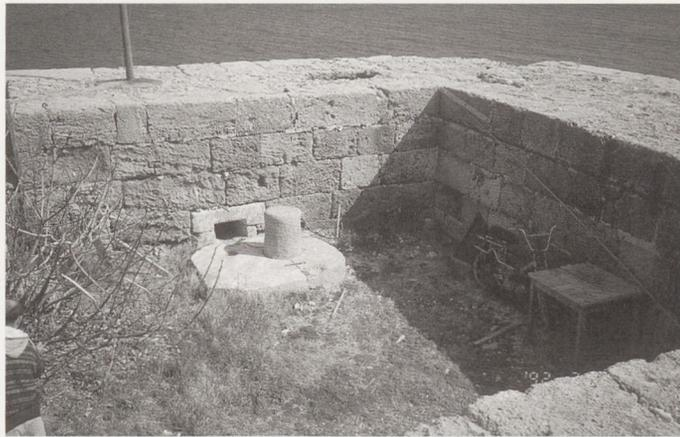
Abb. 26. Rhodos. Turm Naillac am großen Hafen. Im Unterbau aus byzantinischer Zeit ist eine Kammer mit Vorrichtung zum Hochziehen der Hafenkette erhalten.
