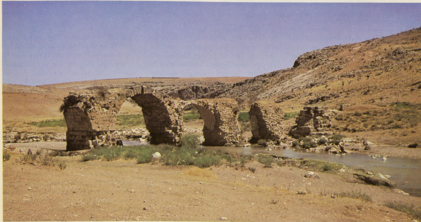
Abb. 69. Römische Brücke über den Karasu. Photo J. Wagner.
