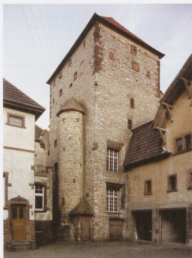
Abb. 6: Burg Wachenheim I. Ansicht des Wohnturms von Nordwesten
