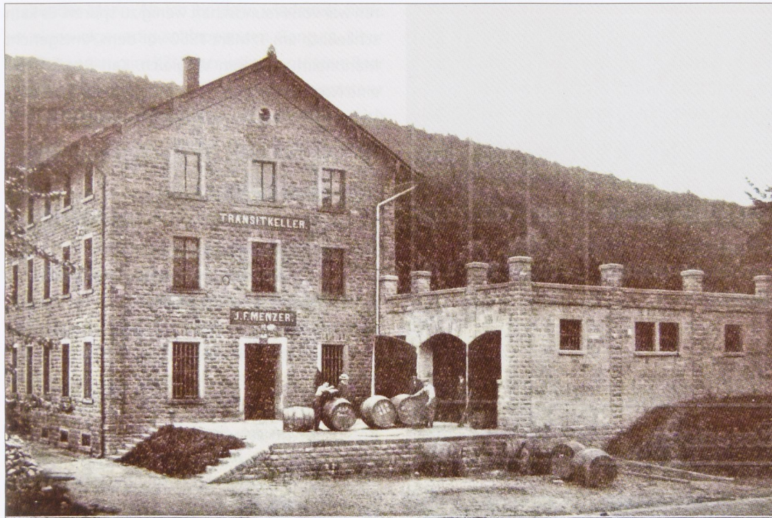
Neuer Transitkeller des Hauses Menzer Neckargemünd.
