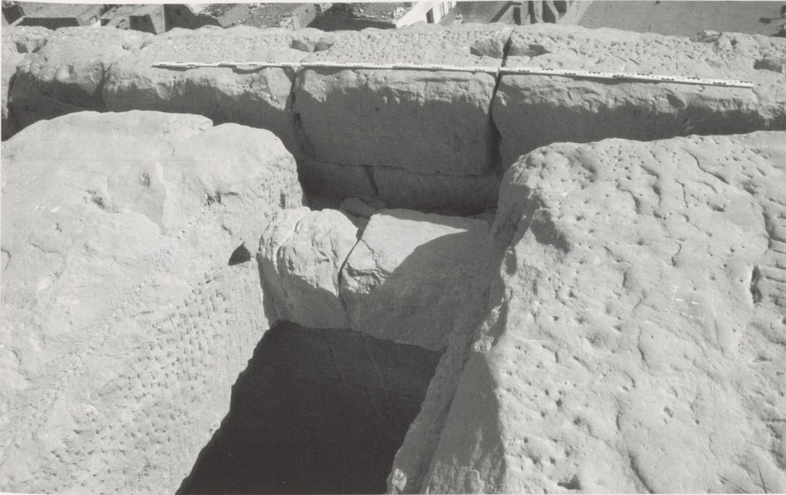
Abb. 3 Eingepasste Blöcke zwischen dem ersten und zweiten Deckenstein von Osten. Entlang der oberen Längskanten der Deckensteine sind Falze ausgearbeitet
