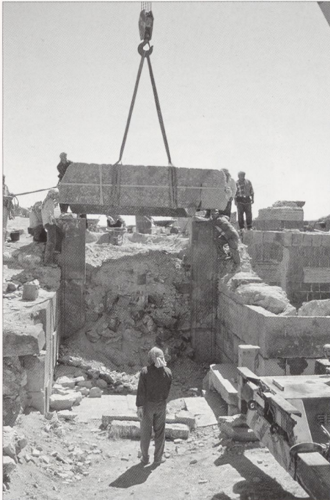
Abb. 8 Androna. Kastron, der restaurierte Sturz des Westtores wird aufgesetzt.
