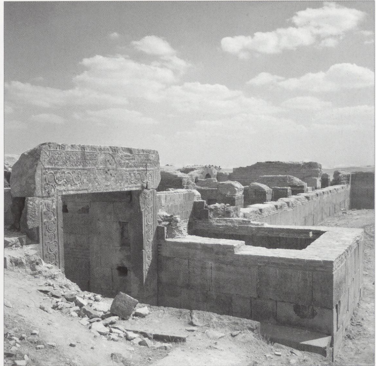
Abb. 9 Androna. Kastron, Ansicht des Westtores und der Westhalle nach der Restaurierung.
