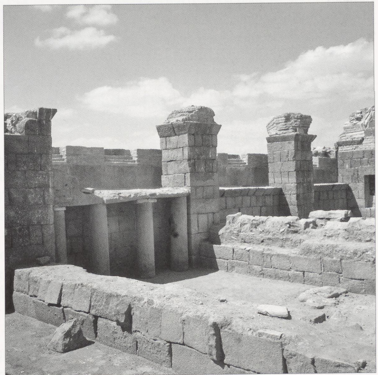
Abb. 12 Androna. Kastron, Westhalle. Blick auf den Wehgang und die späteren Einbauten.
