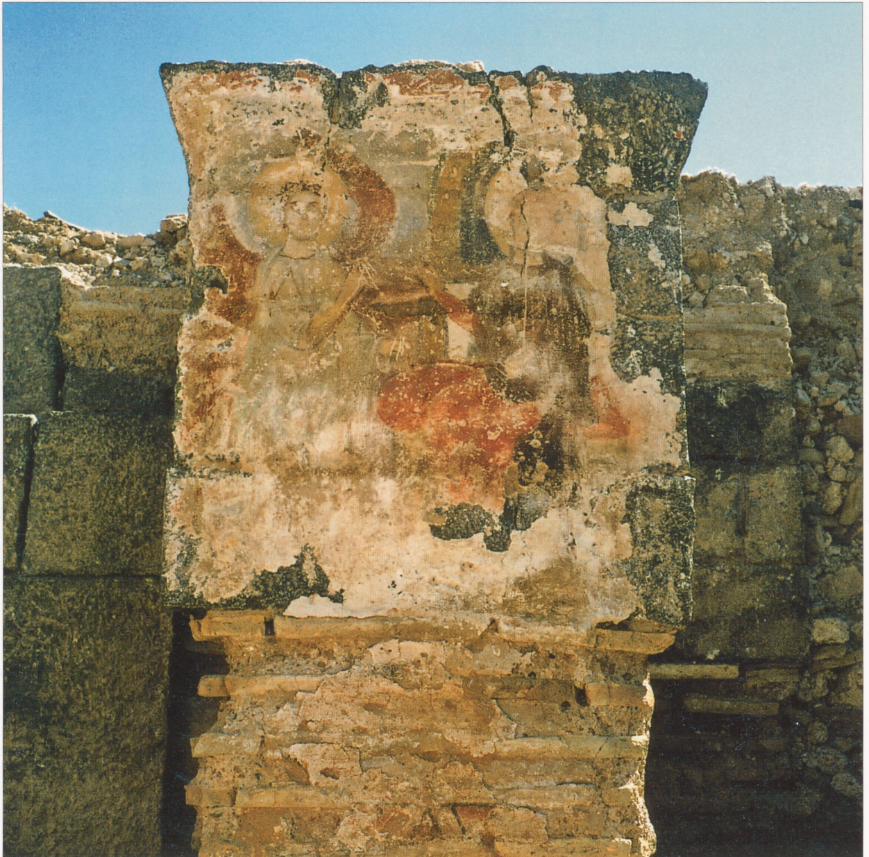
Abb. 16 Androna. Kastron, Westhalle. Ansicht der Malerei auf Pfeiler Nr. 1.
