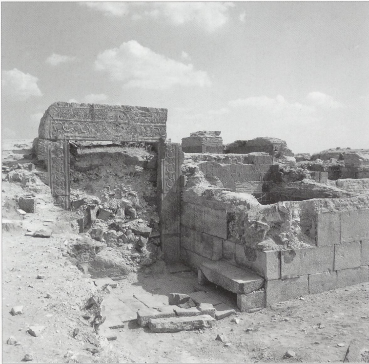
Abb. 7 Androna. Kastron, Westtor mit flankierendem Turm während der Restaurierung.
