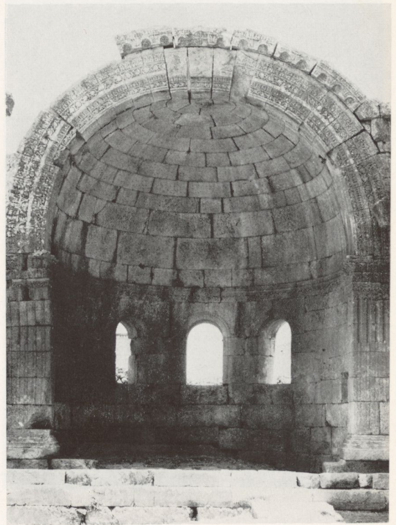
c. Qalbloze. Gesamtansicht der Apsis von innen.
