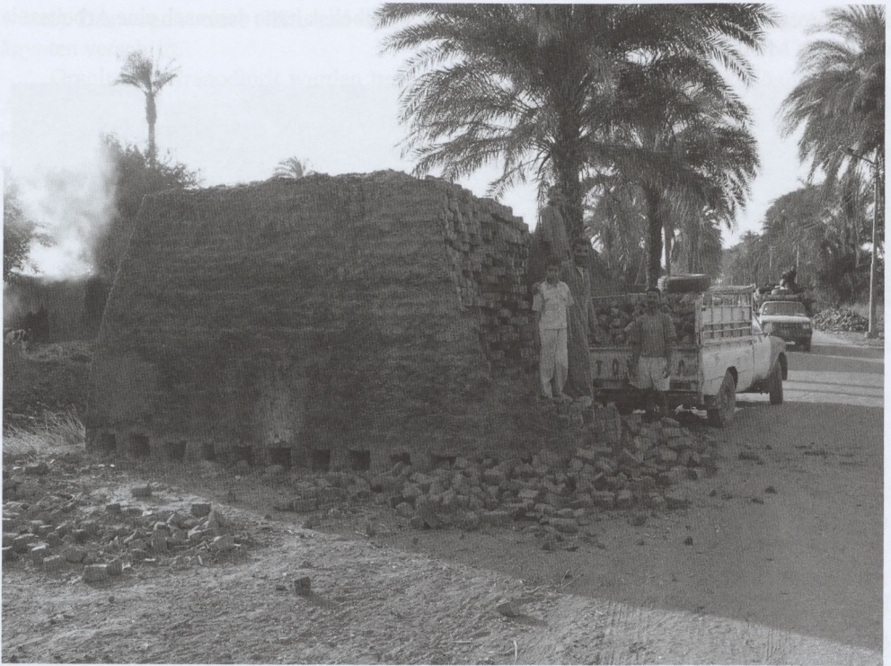
Abb. 1.25: Ziegelbrennerei im Gouvernorat Minia, 2010. Die mit Modeln geformten Ziegel werden zu regelmäßigen Stapeln über einem Brennholzraster aufgeschichtet; dann werden die Außenseiten der Stapel mit Ziegelmasse verstrichen, bevor das Holz in Brand gesteckt wird. Bis zu drei Generationen arbeiten zusammen (Foto: U. Fauerbach).
