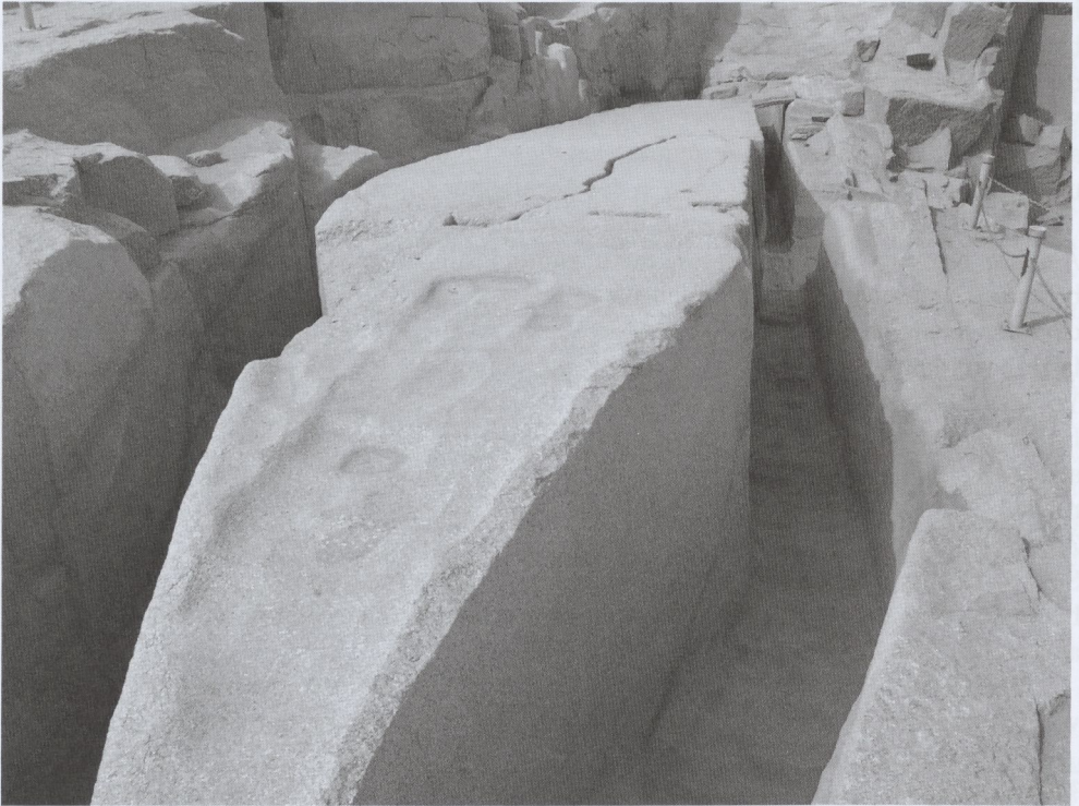
Abb. 1.23: Unvollendeter Obelisk im Granitsteinbruch von Assuan. Die gerundeten Vertiefungen sind Schlagspuren von Dioritwerkzeugen. Die Schrottröben rechts und links des Obelisken boten jeweils einer Reihe von Arbeitern Platz (Foto: U. Fauerbach).
