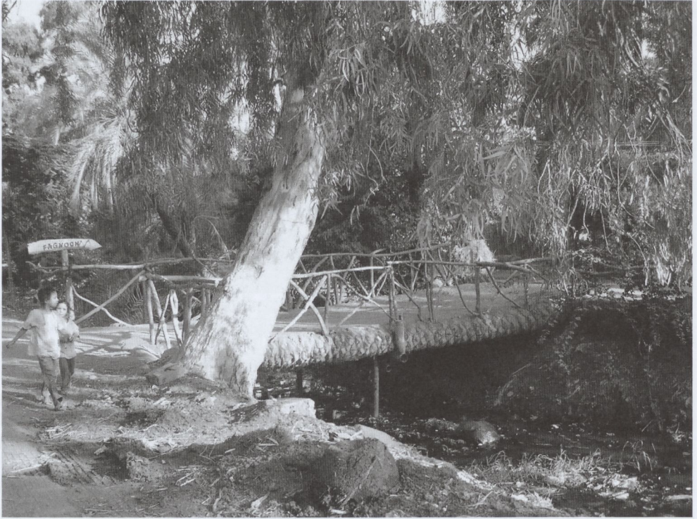
Abb. 1.32: Einfache Brücke über einen Kanal bei Abusir. Die Konstruktion besteht aus Palmstämmen mit einer Lehmdecke, das Geländer wurde aus Astholz zusammengenagelt (Foto: I. Helmedag 2009).
