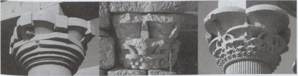
Abb. 1.24: Links: Unfertiges Lilienskapitell in Philae. Außer an der obersten von vier Reihen ist lediglich die horizontale Gliederung erkennbar; der Zustand entspricht also der Zeichnung in Abb. 1.7. Östlicher Dromos, um die Zeitenwende. Mitte: Dieses unvollendete, dreireihige Kapitell aus griechisch-römischer Zeit wurde in Athribis im Kernmauerwerk verbaut. Sein Zustand entspricht dem Modell in Abb. 1.9. Rechts: Vollendetes, fünfreihiges Lilienskapitell in Philae, großer Kiosk, Kaiserzeit (Fotos: U. Fauerbach).
