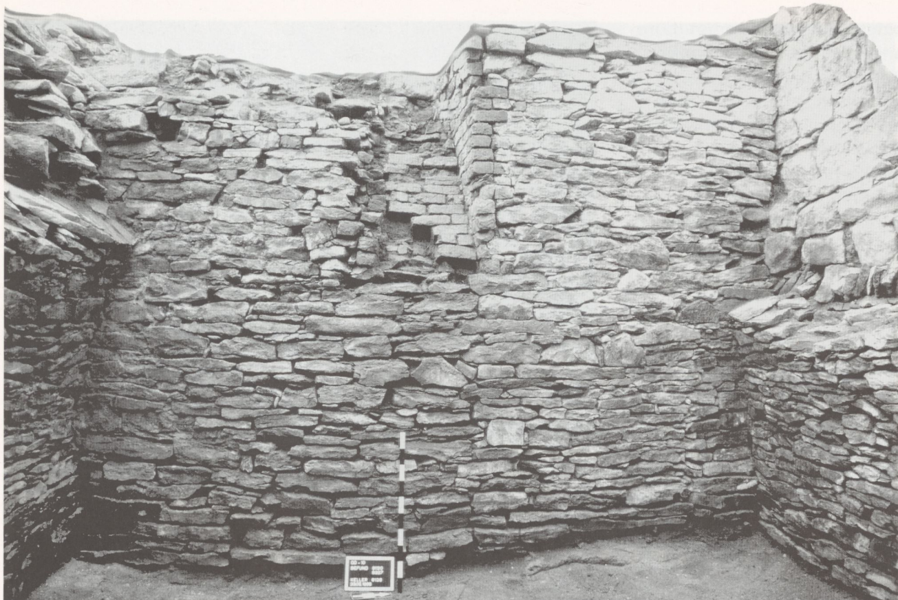
Abb. 7. Westmauer des Steinwerkes Schreibergasse 10 (13. Jh.). Ein Lichtschacht im oberen Bereich der Mauer ist mit Ziegelsteinen gefaßt. Rechts und links sind die Ansätze des Tonnengewölbes aus Bruchsteinen (Plänner) zu erkennen.
