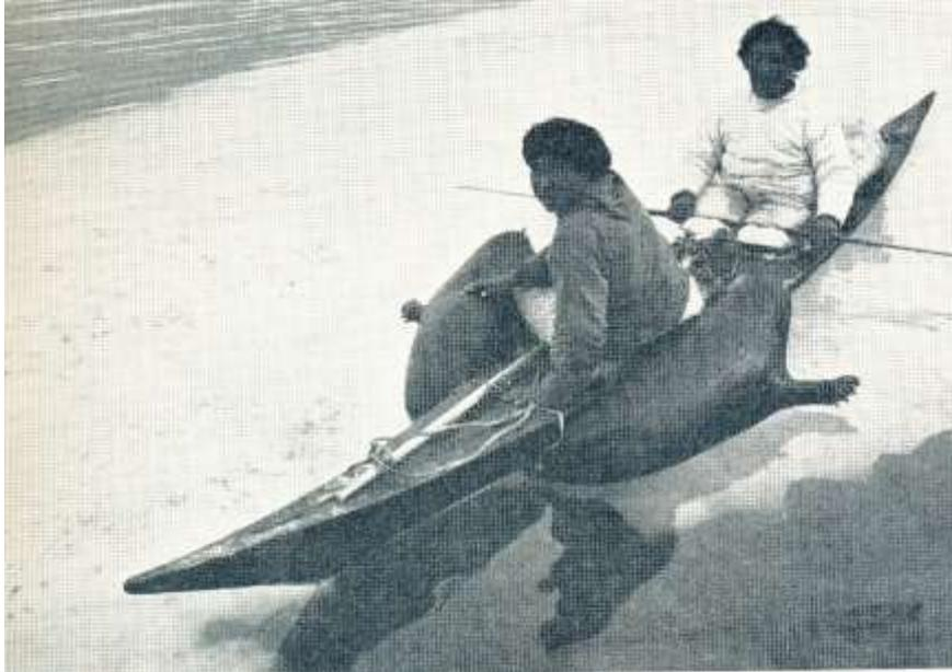
Abb. 113. Auftriebskörper auf beiden Seiten des Kajaks erzeugen den notwendigen Auftrieb zum Transport einer weiteren Person. Grönland. Quelle: Holtved 1967, Abb. 58.
