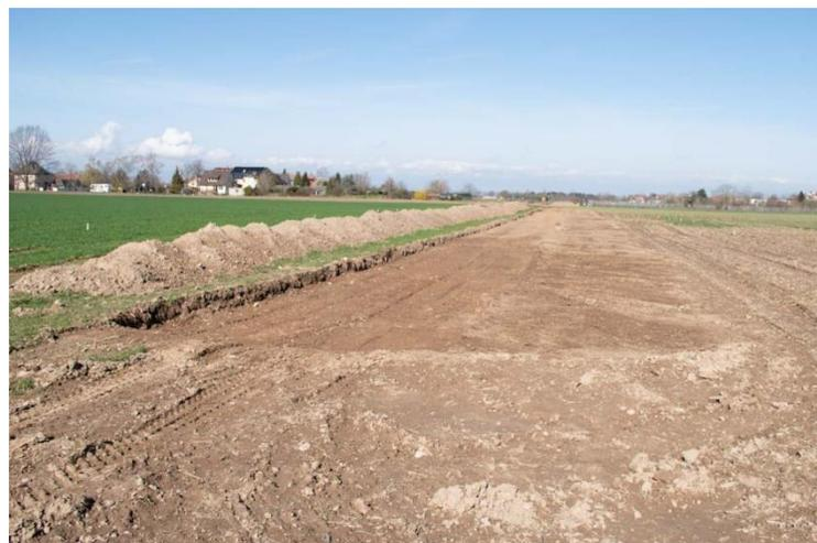
Abbildung 8: Wieder verfüllter und planierter Schnitt 03.
