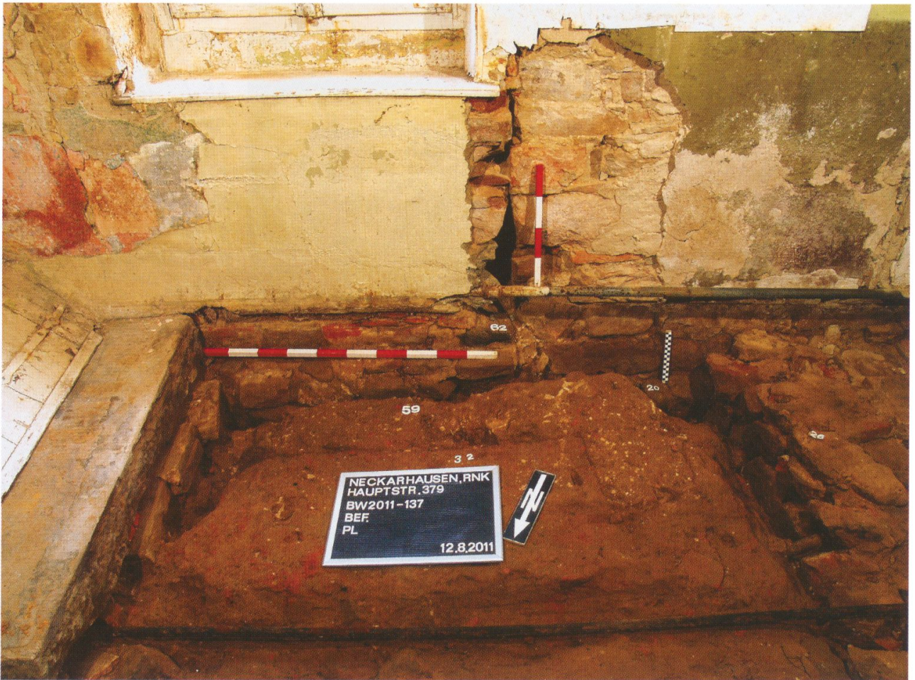
Abb. 32: Befund (59) bildete ein Fundament für den Aufgang in das Obergeschoss. Oberhalb vom Fundament (62) befand sich einst eine Tür zum Hof der Hauptstraße 377. In die Vermauerung wurde ein Fenster gesetzt.
