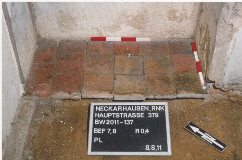
Abb. 44: Tonplatten (7) in der Nahaufnahme. Die letzte Putzfassung des Schornsteins zieht über die Tonplatten.
