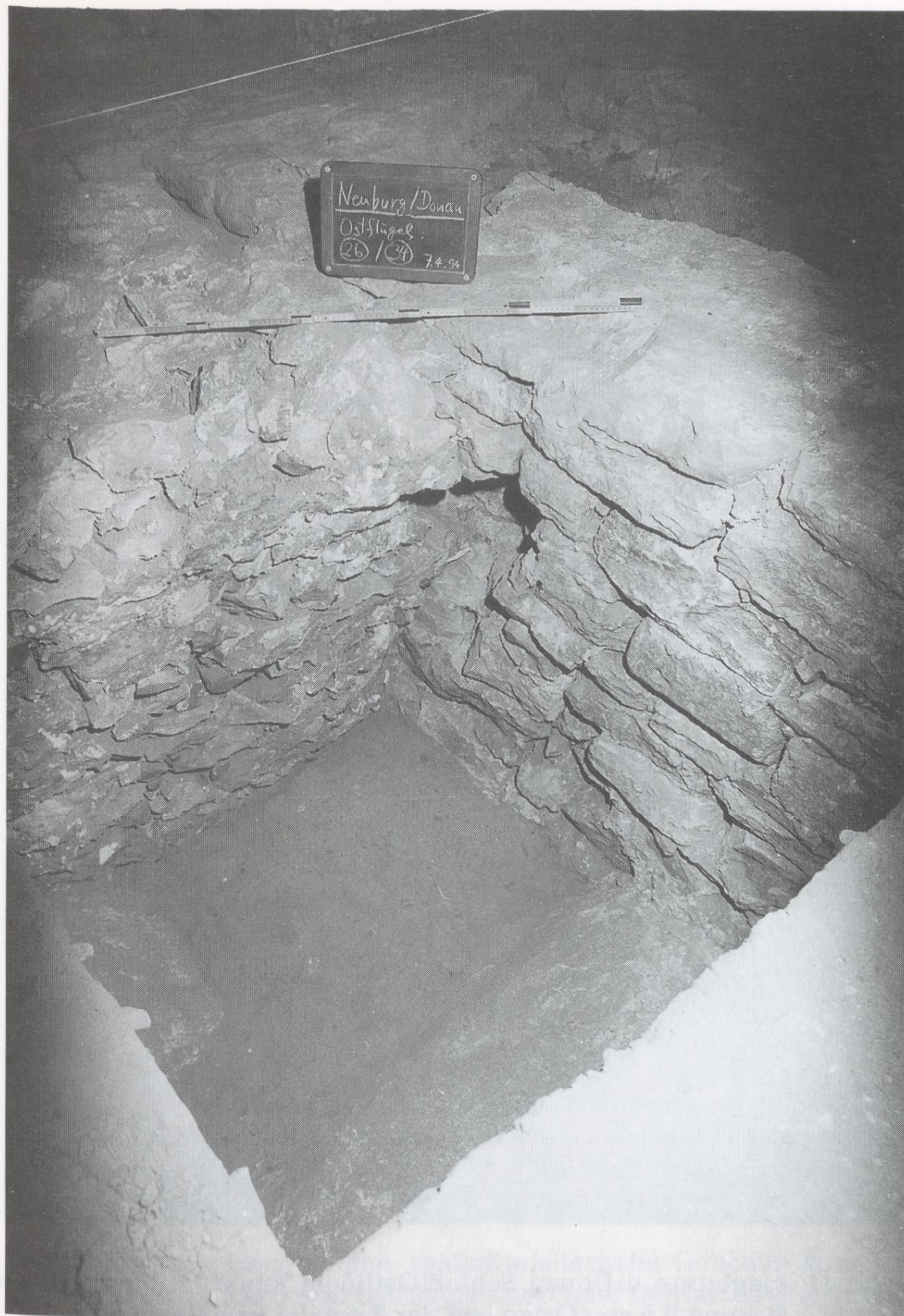
Abb. 10: Neuburg a. d. Donau, Schloß. Ostflügel, Raum 0.2, Fundamente II 1, III 1 und Kellergewölbe II 3 von Südosten.
