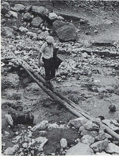
Abb. 5. Improvisierte Behelfsbrücke aus zwei Pappelstämmen über einen Seitenbach des Kunar zwischen Buni und Mastuj. Aufnahme Jettmar 1975
