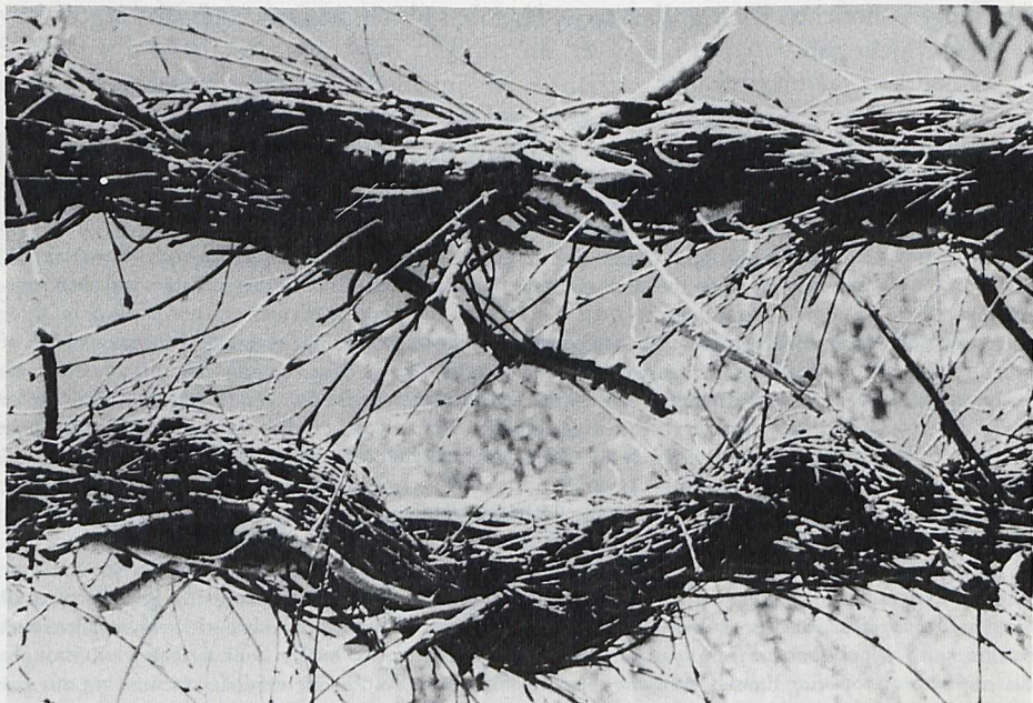
Abb. 4. Die Tragseile sind aus Weidenzweigen geflochten. Aufnahme Jettmar 1958
