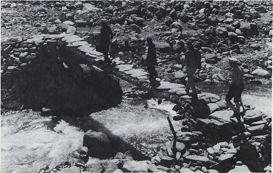
Abb. 7. Reguläre Balkenbrücke im Lotkuh-Tal/Chitral. Aufnahme Jettmar 1975
