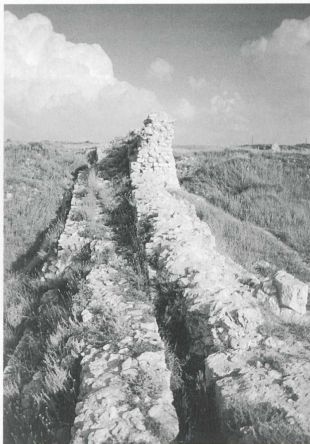
Abb. 6 – Byzantinische Stadtmauer in Chersonesos im Westen nach Süden (Aufnahme der Verf.).
