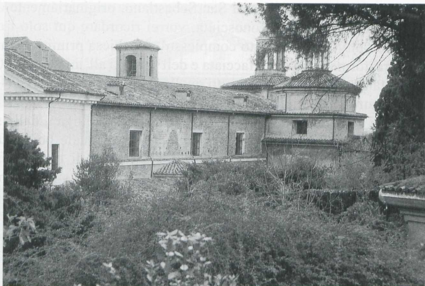
FIG. 2 - L'angolo nord-est della basilica di San Sebastiano con il muro laterale primitivo e la facciata barocca (foto E. Jastrzębowska).
