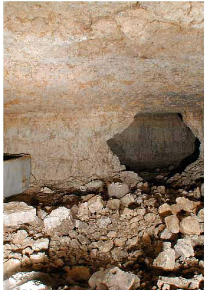
Abb. 11: Gesteinsbrocken, die im Verlauf der über 3300 Jahre langen Verschüttung der Grabkammern von der Decke der Hauptkammer auf das Inventar gefallen sind.
