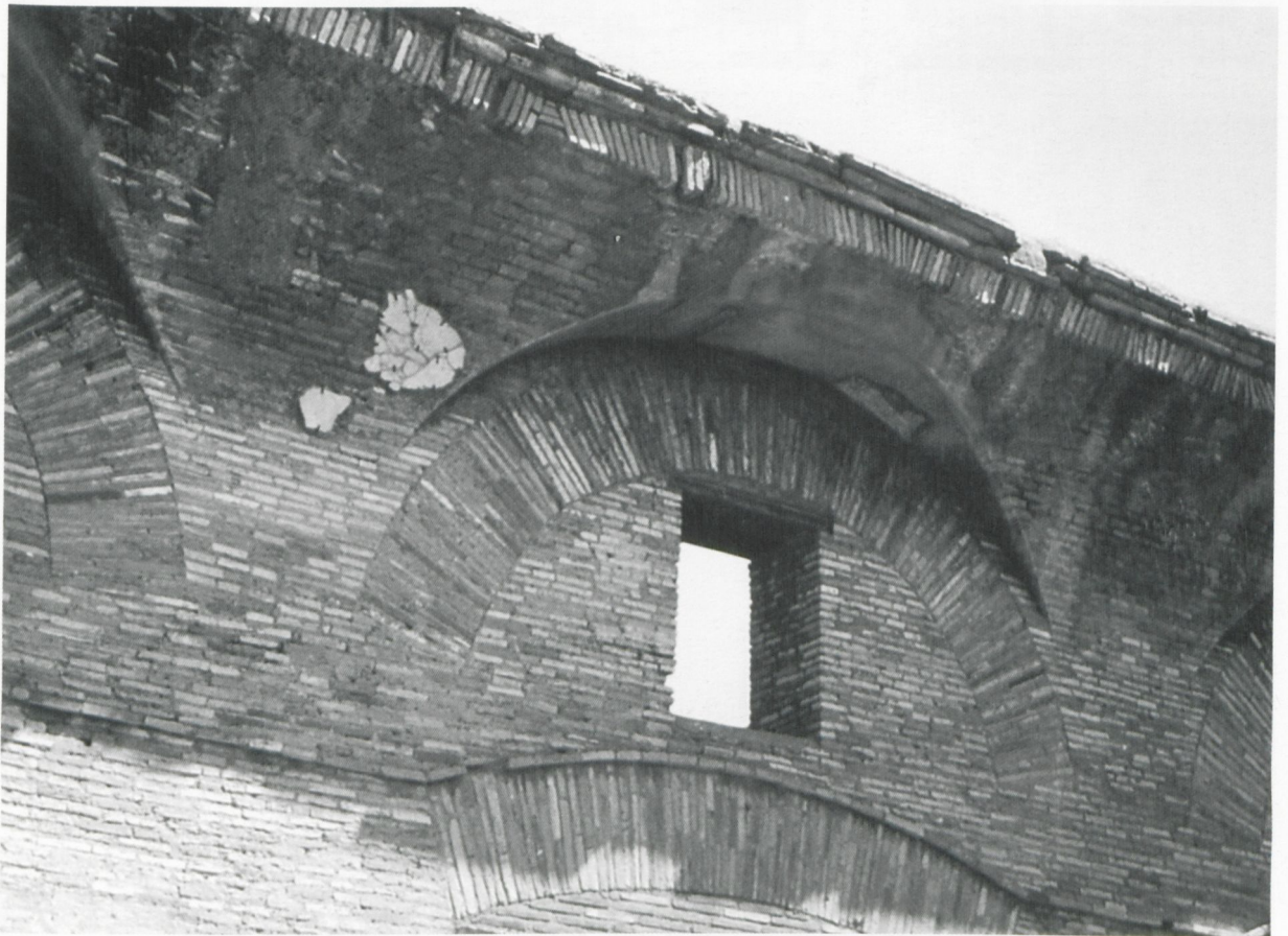
21. Innocenzo Sabbatini, Edificio amministrativo con bagni pubblici, particolare del balcone 22. Ostia, Casa di Diana, balcone, particolare
