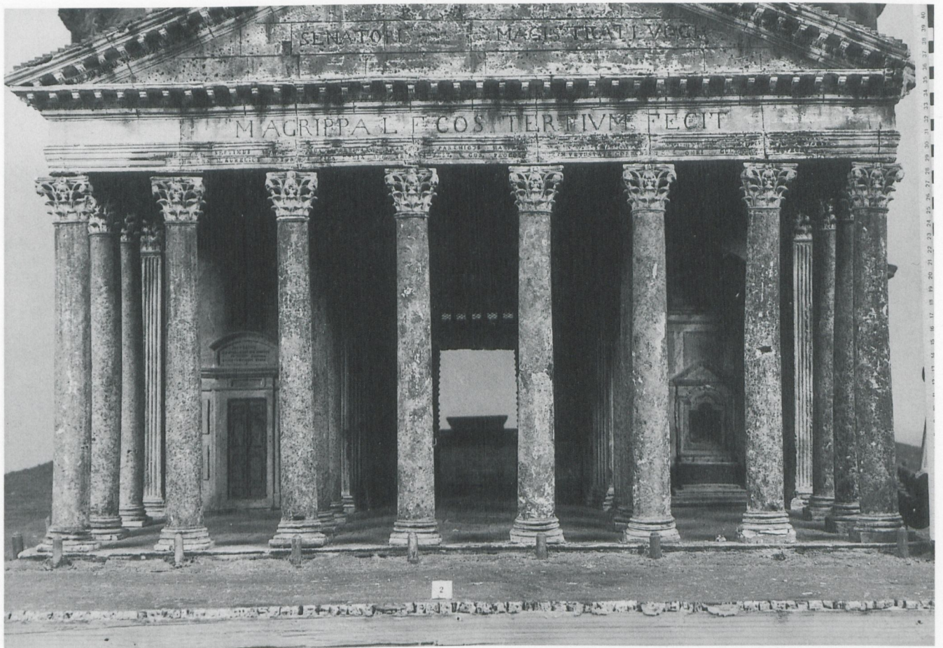
Abb. 84 Kat. 17, Pantheon. Vorhalle des Modells von Georg May vor der Restaurierung. (Foto: Münchner Werkstätten)
