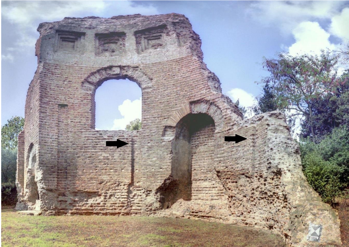
Abb. 25: Rom, Villa des Maxentius, Palastaula: die beiden Abzüge, die in einer Fensteröffnung enden; links im Bild der westlichste Abzug der Apsis in voller Höhe.
