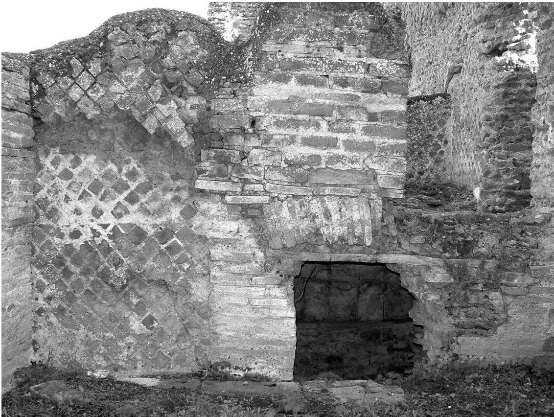
Abb. 66: Tivoli, Villa Hadriana, Winterpalast SO-Bereich; die dritte aus verschiedenen Baumaterialien zusammengefügte Mauer (O) mit nachträglich eingefügter Schüröffnung.
