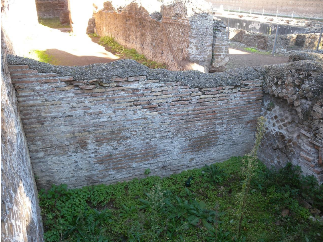
Abb. 67: Tivoli, Villa Hadriana, Winterpalast SO-Bereich; die vierte aus Ziegeln nachträglich eingebaute Mauer (N).
