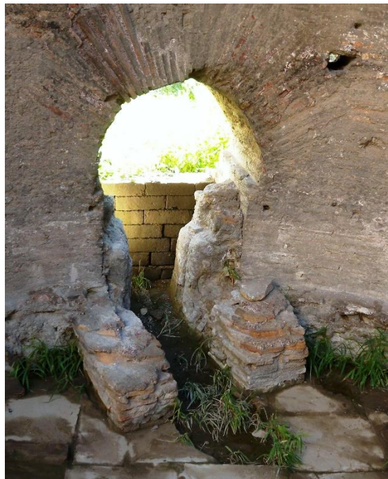
Abb. 40: Rom, Tempio di Minerva Medica; so sieht das praefurnium heute aus; die Umbauphasen sind gut erkennbar.
