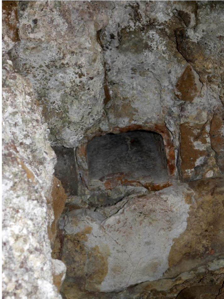
Abb. 58: Tivoli, Villa Hadriana, Winterpalast; Übergang vom gemauerten Teil des Abzugs in den Tubulusstrang.
