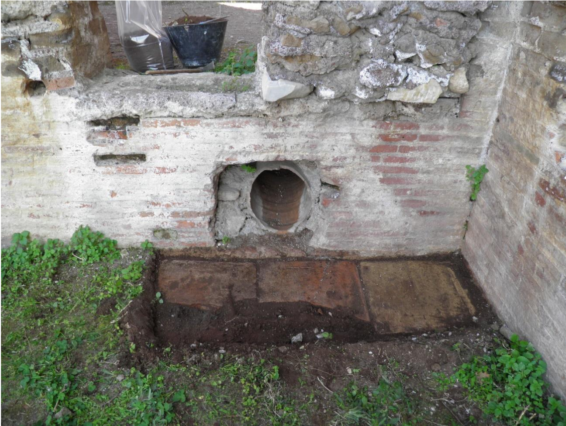
Abb. 68: Tivoli, Villa Hadriana, Winterpalast; Beginn des Tonrohrs (D = 28 cm) in Raum 2.
