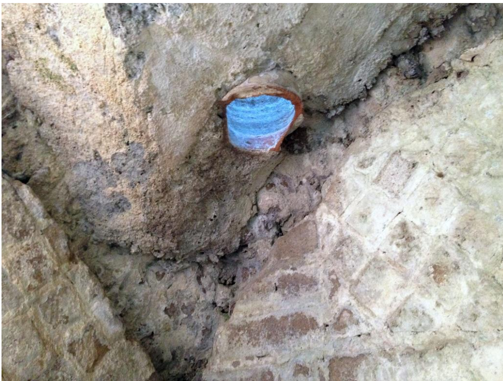
Abb. 63: Tivoli, Villa Hadriana, Winterpalast SO-Bereich; das Rohr L5; auf Grund seiner Dimension und Positionierung lässt es eher an eine Entlüftung des Bedienungsgangs denken.
