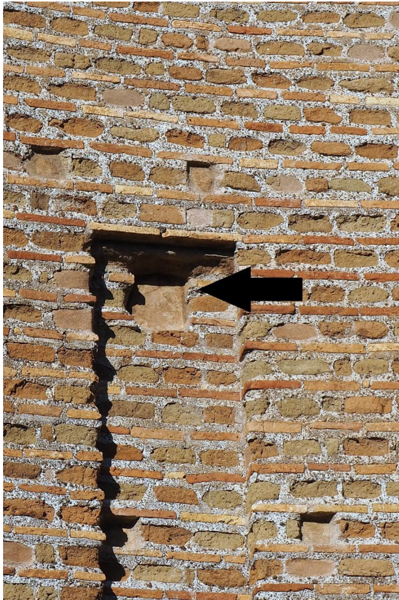
Abb. 24: Rom, Villa des Maxentius, Palastaula: Ansatz für einen Durchbruch nach außen im westlichen Abzug der Apsis.
