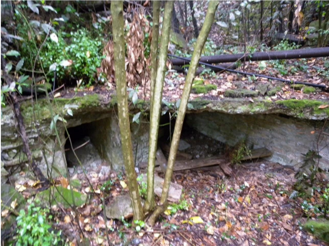
Abb. 4: Rom, Villa des Maxentius, Gebäude L1: Zustand 2017.
