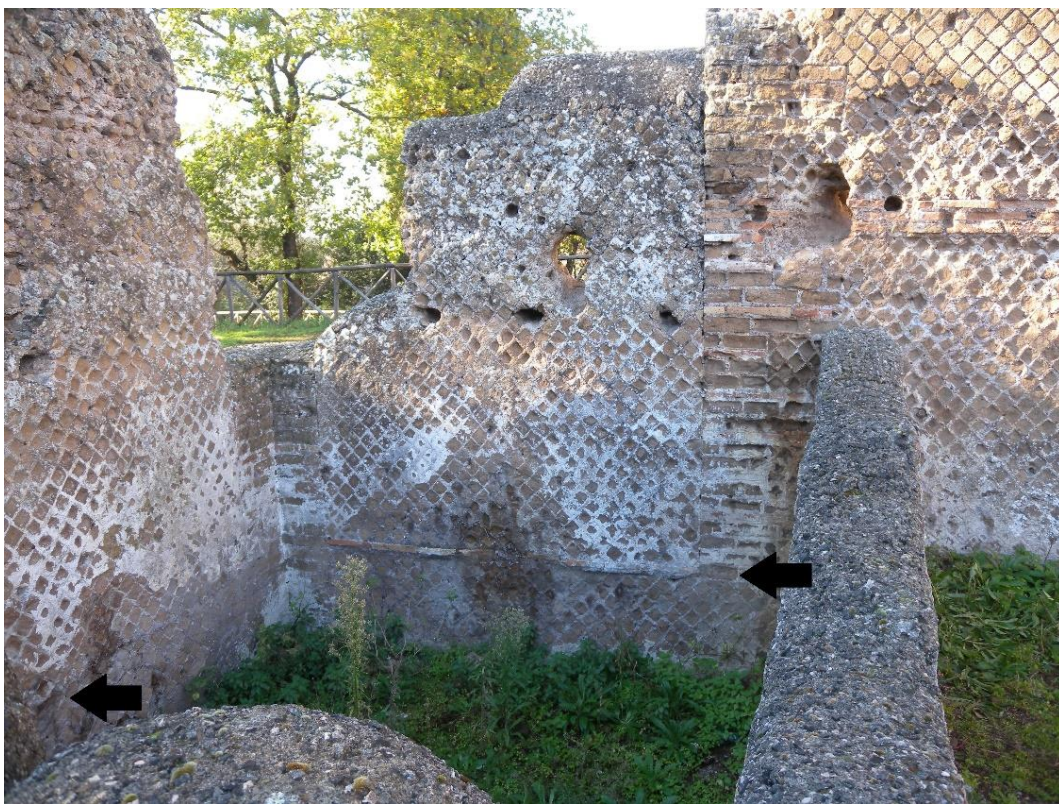
Abb. 65: Tivoli, Villa Hadriana, Winterpalast SO-Bereich; die beiden Mauern (S und W) aus opus reticulatum mit möglichen Spuren einer suspensura .
