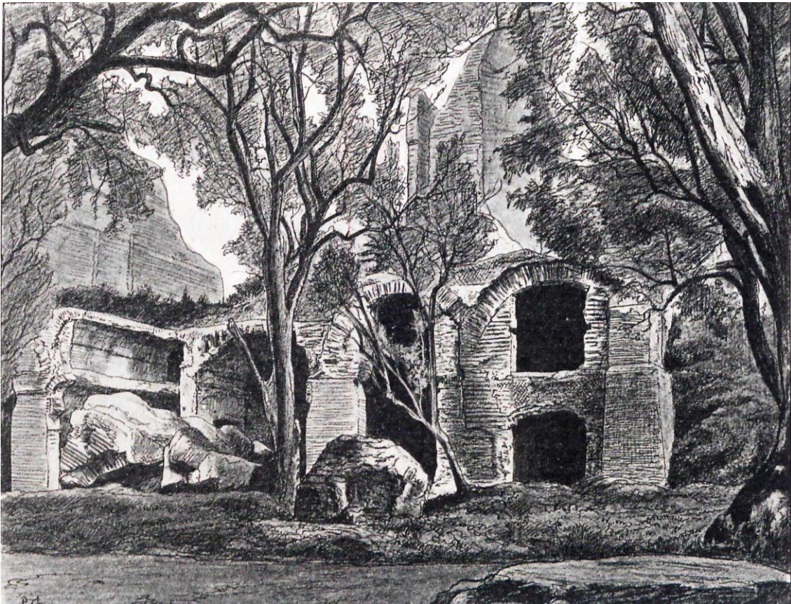
Abb. 45: Tivoli, Villa Hadriana, Winterpalast; Ansicht 1904 76 : der gesamte vordere Teil des Bauwerks ist weitgehend eingestürzt; im linken Bereich scheint der Bedienungsgang zumindest bis in den Bereich des Schachts S1 (siehe Abb. 49) zu fehlen.
