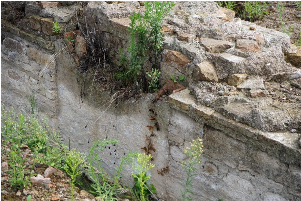
Abb. 23: Rom, Villa des Maxentius, Palastaula: bis zum Unterboden des Hypokausts heruntergezogene, verputzte Tubulusstränge an der Westseite der Palastaula.
