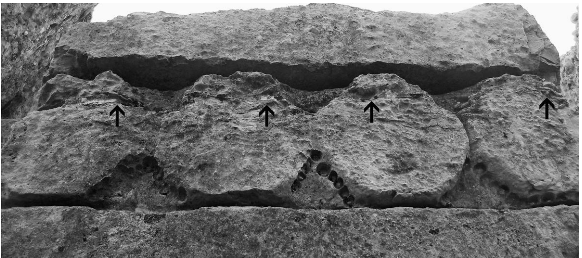
Εικ. 16: Λεπτομέρεια του θριγκού της Πύλης των Λεόντων, που δεικνύει τις σπές από την εφαρμογή σωληνοειδούς τρυπανιού και τα ίχνη του πριονιού. Τα βέλη υποδεικνύουν την εσφαλμένη θέση κοπής με το πριόνι και την επισκευή με άγνωστο υλικό πληρώσεως
