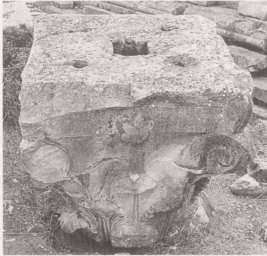
Abb. 16. Wie Abb. 15. Oberseite des unfertigen korinthischen Kapitells mit Dübellöchern und Wolfsloch
