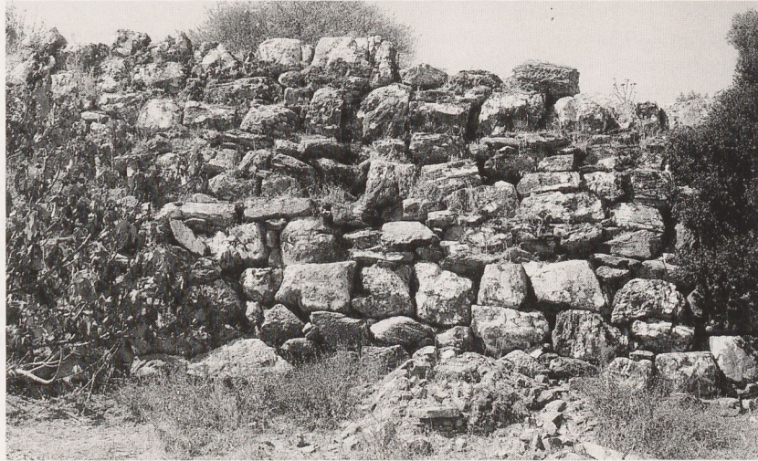
Abb. 2. Bruchsteinmauer der Terrasse des Mausoleums
