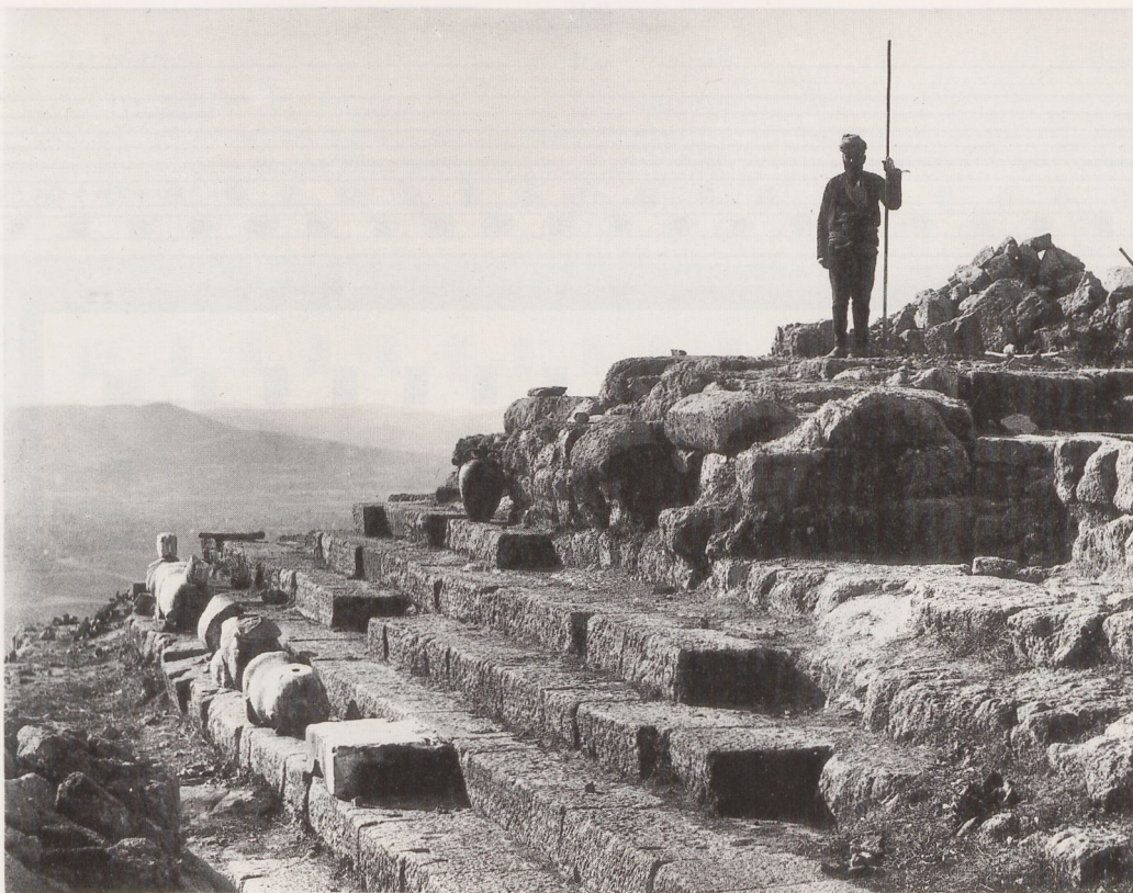
Abb. 4. Pergamonaltar. Stufen und Stufenfundament auf der Ostseite. Fotografie während der Ausgrabung um 1880
