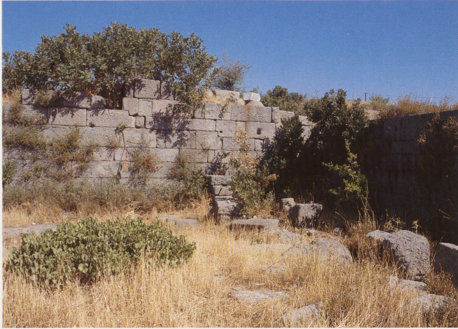
Abb. 60 Pergamon. Nordwand des großen Saals mit Löchern in regelmäßigen Abständen. Aufnahme aus dem Jahre 2000.
