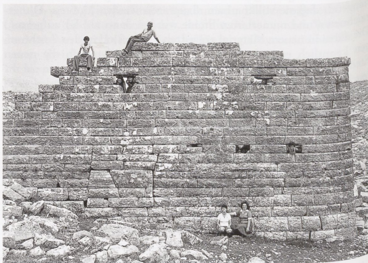
Orraon. Haus 1, westliche Straßenfront mit Fenstern, Gesims und in situ befindlichen Steinen eines Giebels (1976)
