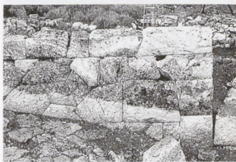
Kassope. Außenmauer von Haus 3 in polygonaler Technik
