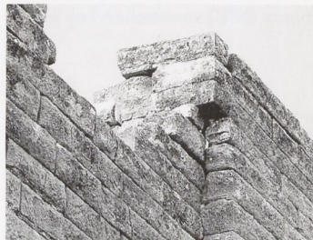
Orraon. Haus 1, im Gesimsbereich vor- springende Quader auf der Südseite (1976)
