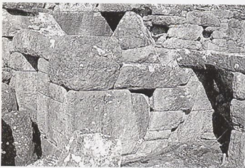
Dystos. Ecke des Andron von Südosten. Links die Tür zum Männerraum, rechts die Tür von der Prostas zum Hof (1977)
