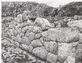
Kassope. Straße 6 und Außenmauer von Haus 1 in polygonaler Technik
