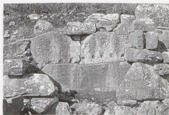
Dystos. Westliche Außenwand des Dromos im Bereich des Andron-Turms (1977)
