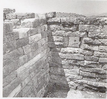
Orraon. Haus 1, südöstliche Ecke des Andron mit Boden aus kleinen Bruchsteinen und Außenfenster (1986)
