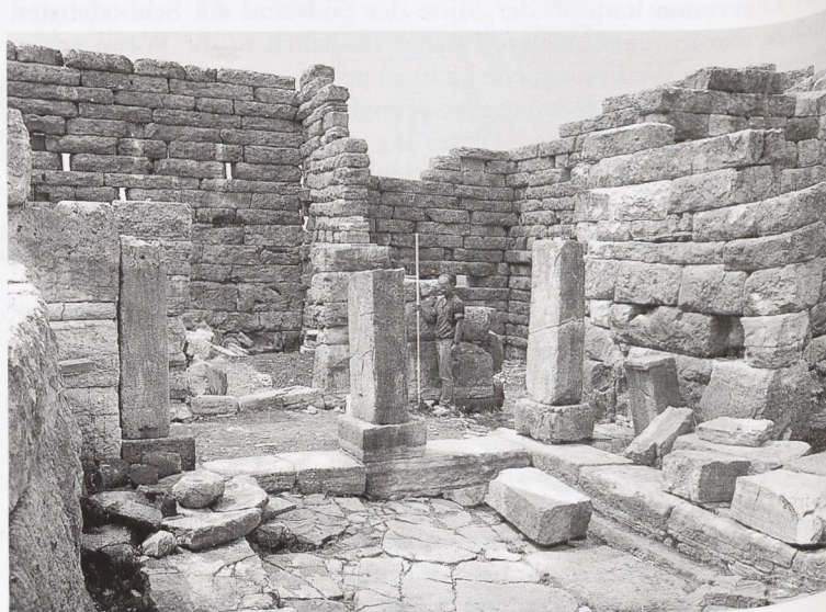
Orraon. Haus 1, Schwelle im Andron mit Einlassungen für hölzernes Gewände, Pfannen und Riegellöchern für die Türblätter (1986)
