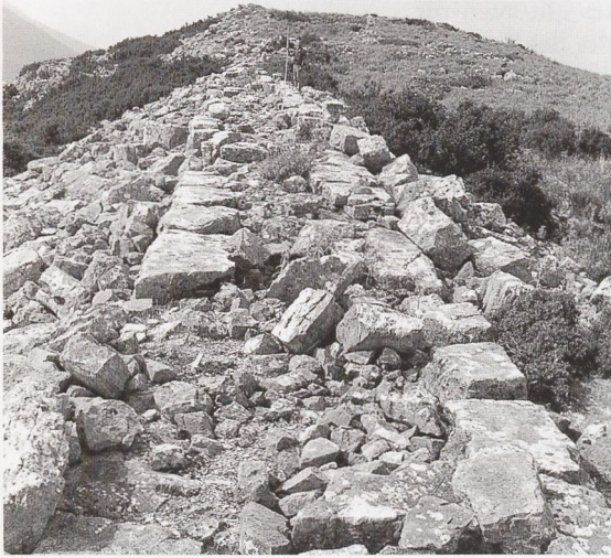
Orraon. Stadtmauer im Osten, Blick nach Süden (1986)
