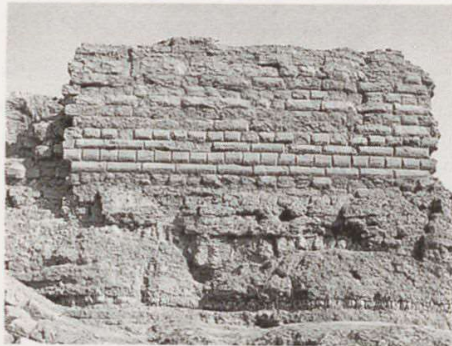
Dura Europos. Der Palast des vom König eingesetzten Strategen und der Tempel des Zeus Megistos lagen auf einem Hügel östlich der Wohnstadt, abgestützt von einer hohen Terrassenmauer mit Buckelquadern (1984)
