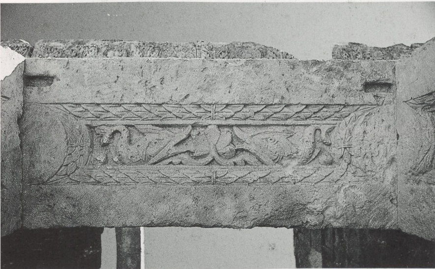
Abb. 28: d.s., Seitentür W-Fassade.
