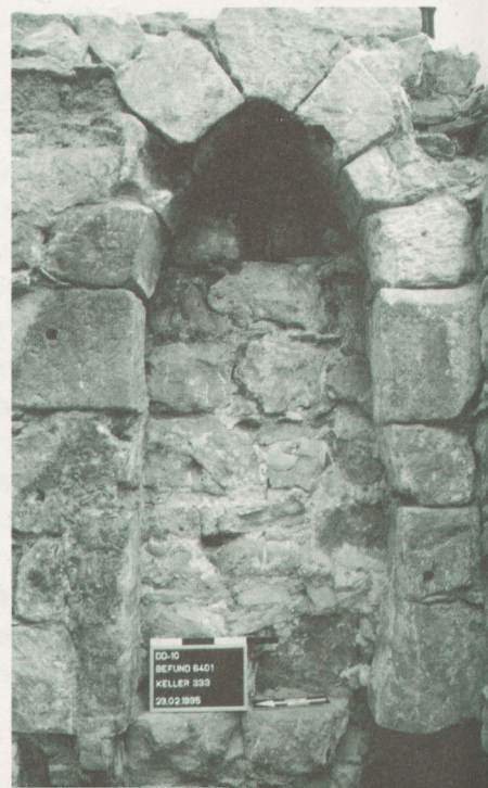
Abb. 8. Nische mit Spitzbogen aus Sandsteinquadern im Keller des Vorderhauses Altmarkt 13.
