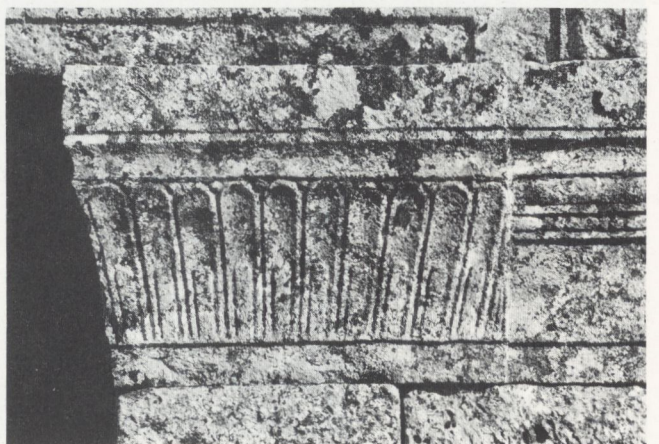
6 Kaukanaya. Sog. Königshaus, Kapitell der Südportikus.
