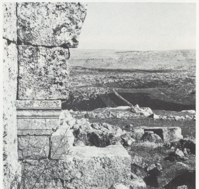
4 Işruq. Kirche, Ostwand, Nordteil von innen.
