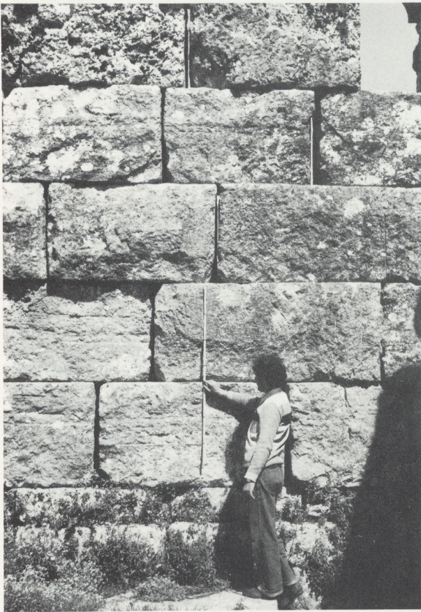
1 Banaqfur. Kirche, Nordwand, östlicher Teil.
