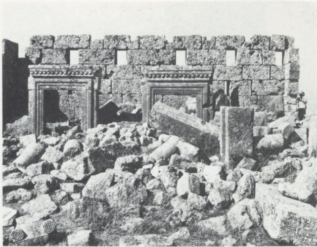
1 Işruq. Kirche, Ansicht von Süden.
