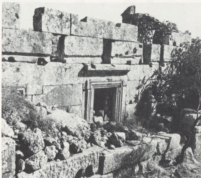
1 Marmaya. Kirche, Ansicht von Südwesten.
