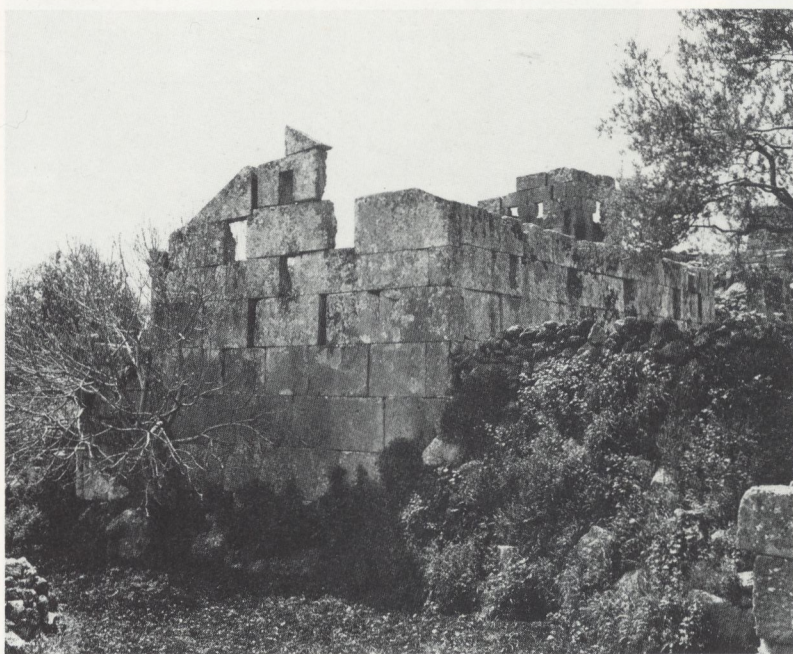
3 Marmaya. Kirche, Ansicht von Nordosten.
