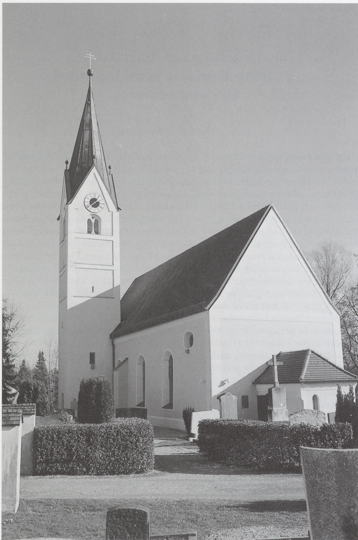
1 Markt Indersdorf, Marktkirche St. Bartholomäus. Ansicht von WNW
