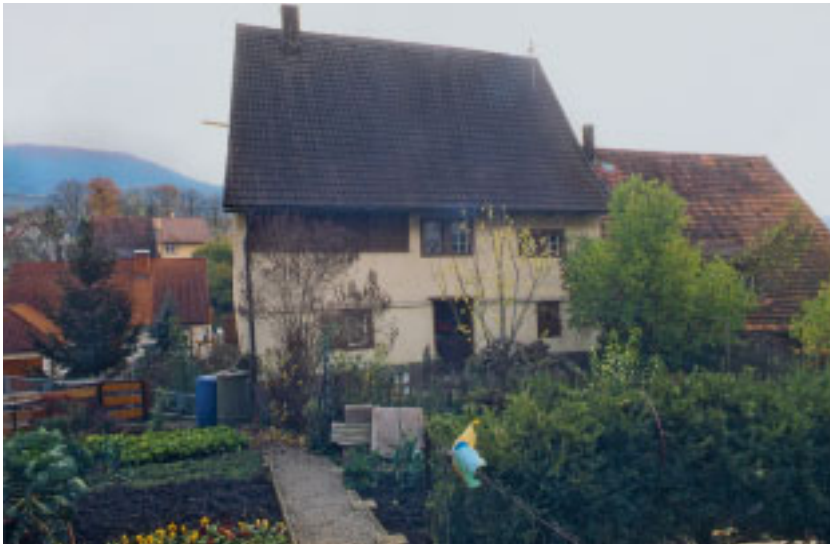
4 Ansicht der Gartenfascade vor Beginn der Instandsetzungsmaßnahmen; im Obergeschoss der ehemalige Abortgang mit Schiebeläden.
