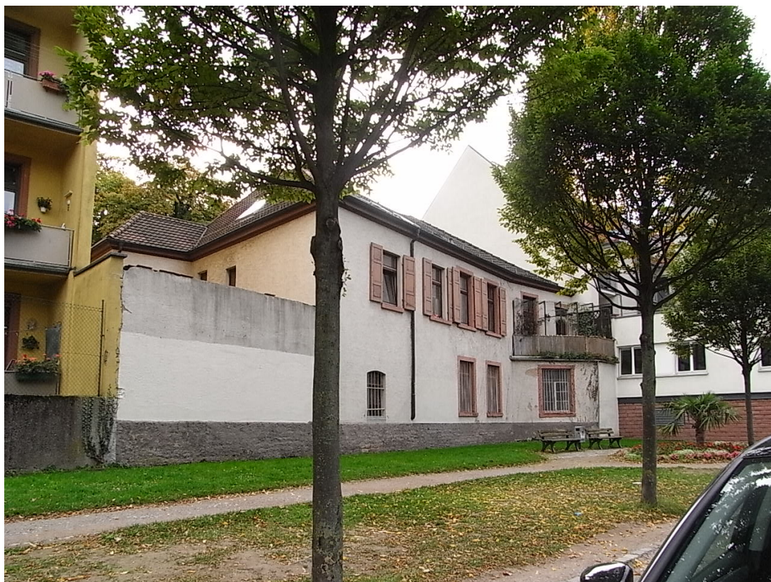
Reste der alten Ölmühle am Neckarufer
