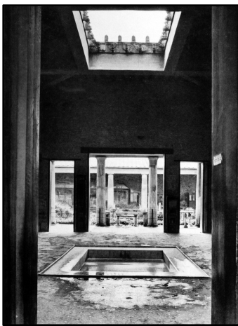
Fig. 47. Pompei, Casa dei Vettii (6 15, 1), atrio (c): tetto con gocciolatoi a protome canina (H. DRERUP, Bildraum und Realraum in der römischen Architektur , in MDAI(R) 66, 1959, tav. 40)
