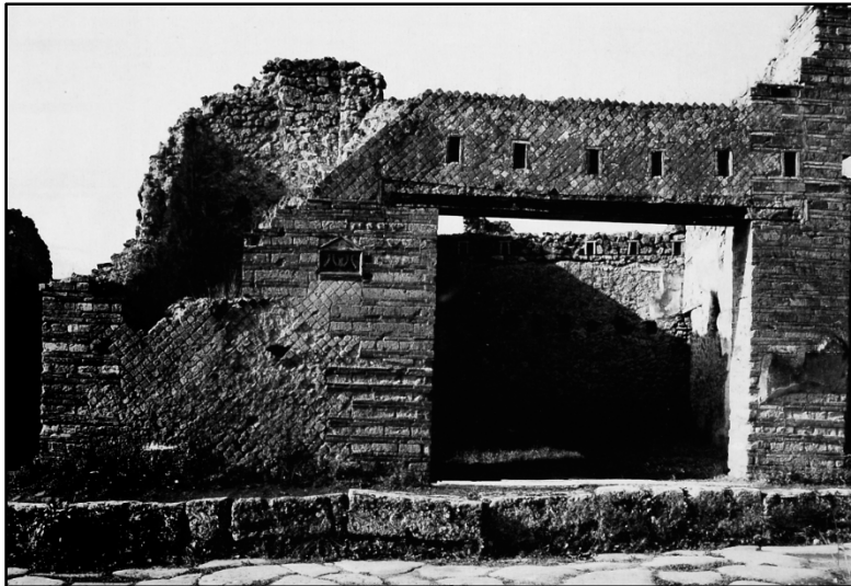
Fig. 114. Facciata della casa dopo il crollo del piano superiore in seguito a un bombardamento della II Guerra mondiale (BRAGANTINI 1994, p. 342, fig. 2)
