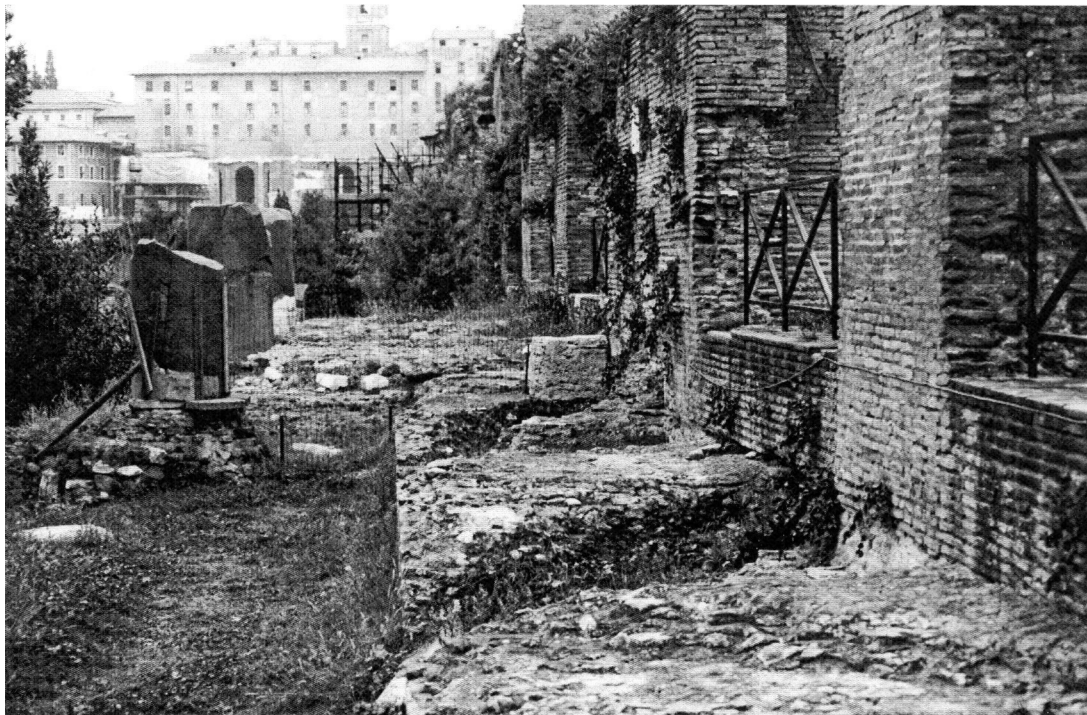
Abb. 42: Südseite, Terrassenvorsprung und Reste der Eingangsportikus von Osten gesehen. Foto Schumacher SW V,14.
