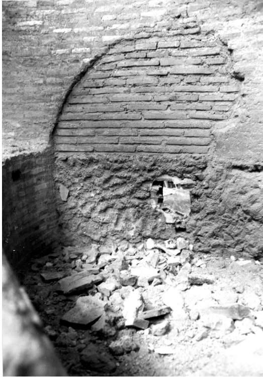
Abb. 29: Nordöstliche Außenwand, Rundnische zum Gang des Clivus Veneris Felicis, Detail: Nachträglich zugemauerter Eingang.
