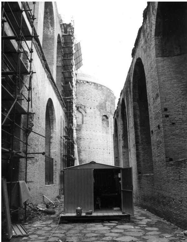
Abb. 31: Ansicht des Umgangskorridors an der Nordwestseite der Basilika.
