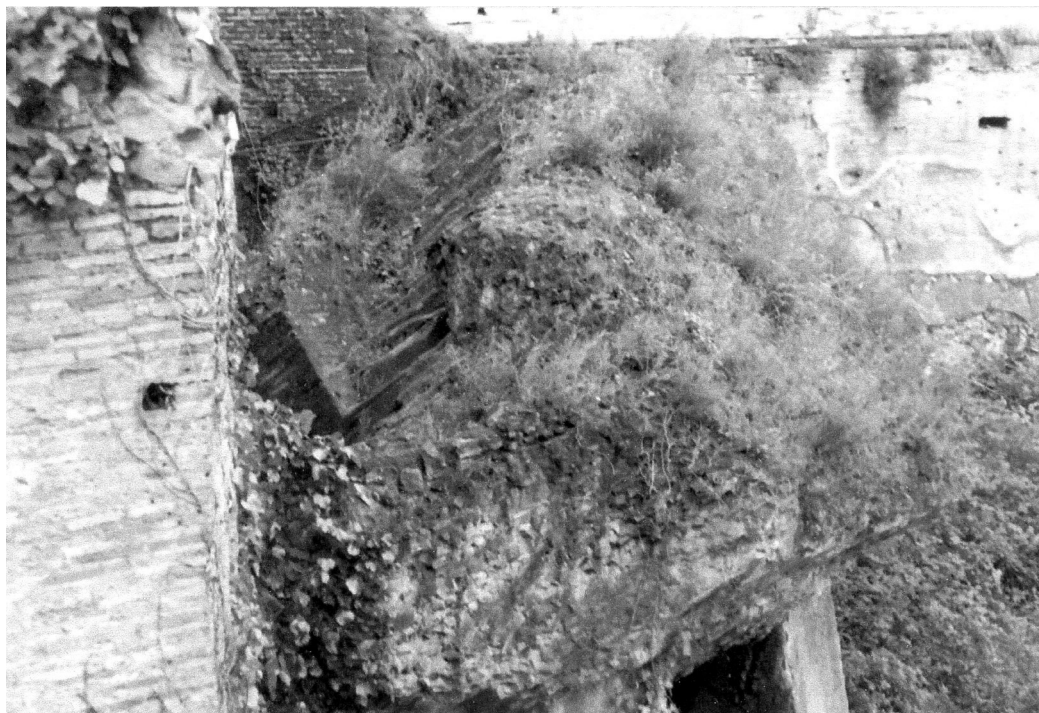
Abb. 56: Clivus ad Carinas, herabgestürztes Fragment eines Strebepfeilers vom Seitenschiffdach mit Resten der Wendeltreppe.
