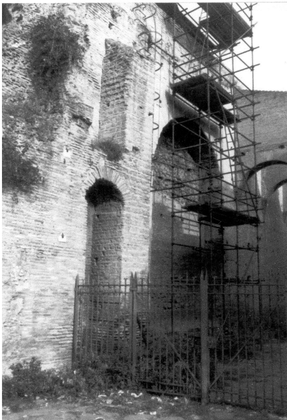
Abb. 22: Ostnarthex, Detail: zugemauertes, nördlichstes Fenster. Foto Schumacher SW V, 32.
