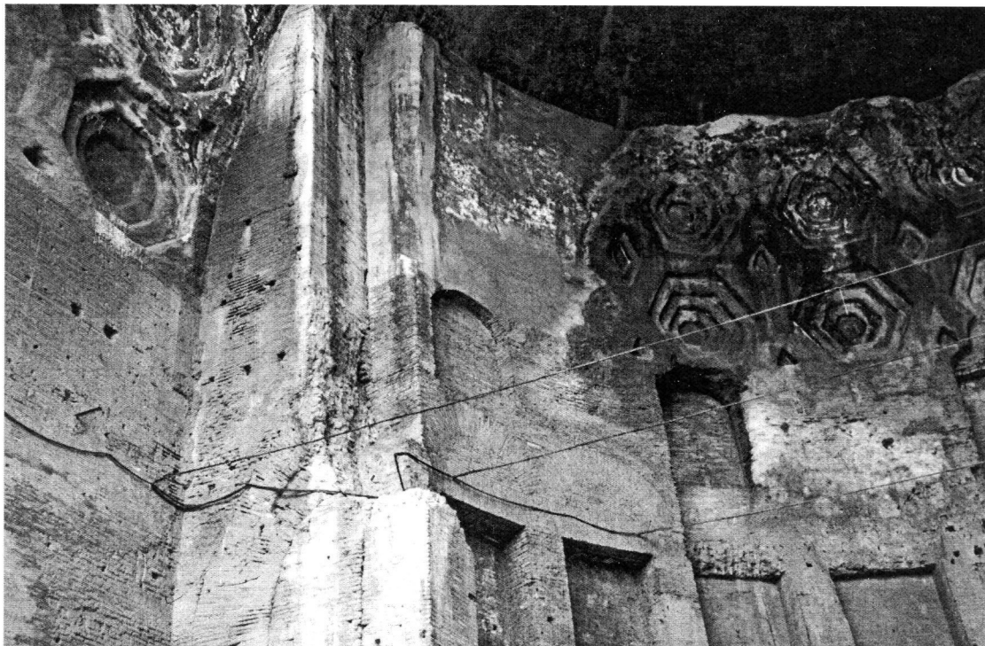
Abb. 35: Nordapsis von Süden, Detail: östliche Stirnwand mit Spuren der ehemaligen vermauerten Fenster.
