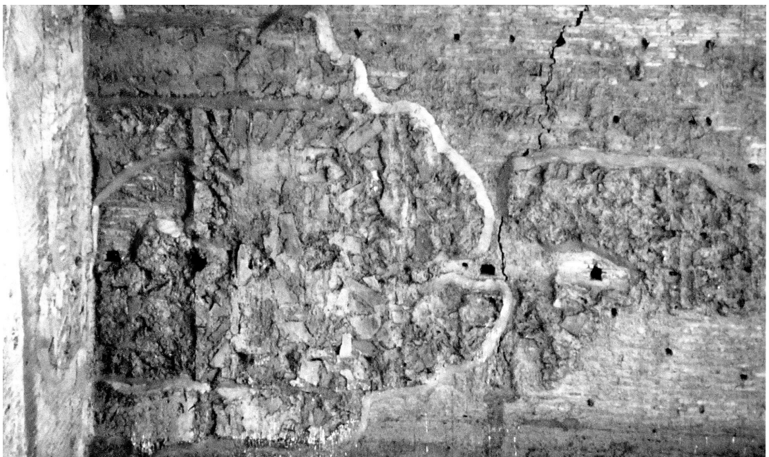
Abb. 62: Einbettungsspuren der Wandinkrustation.
