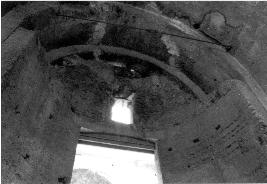
Abb. 27: Ostnarthex, Nordseite, nachträglich eingebaute Apsis, Detail: Apsiskalotte Foto Schumacher 6/94 II,25.
