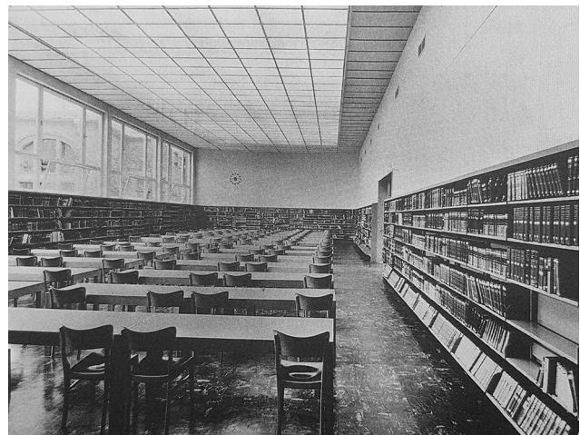
Abb. 2: Lesesaal (1955) nach dem Abbruch des alten Lesesaals (Foto Lossen) 6
