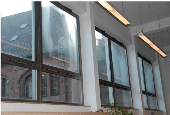
Abb. 5: Multimediazentrum (2014), Fensterfront mit blinden Fenstern (Foto: Martin Nissen)
