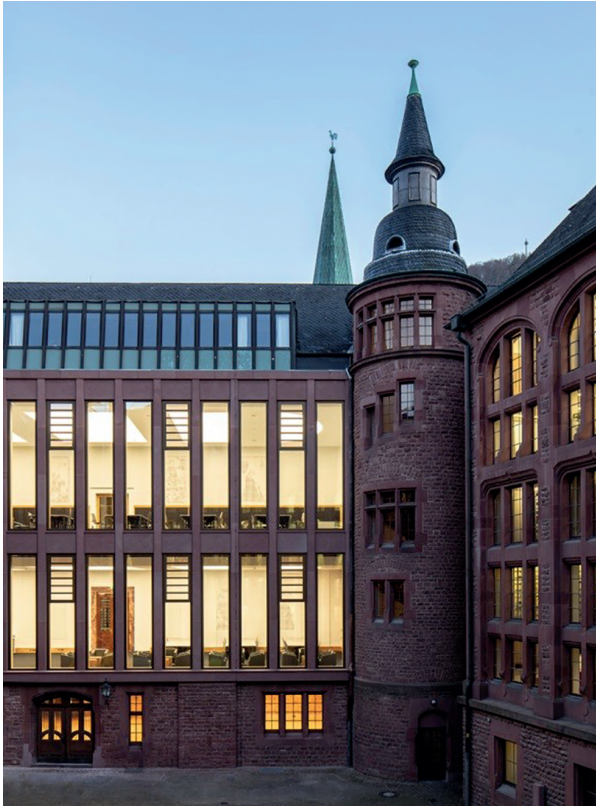
Abb. 6: Neu gestaltete Nordfassade des Südflügels 2019 (Foto: Altenkirch)
