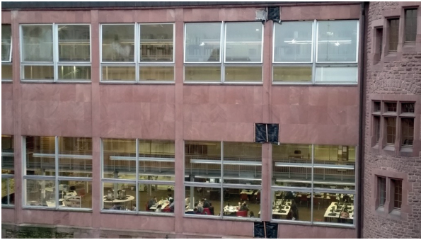
Abb. 4: Nordfassade des Südflügels (2017), mit abgenommenen Sandsteinplatten (Foto: Martin Nissen)
