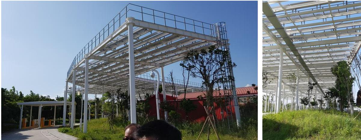
Abbildung 5: Solaranlage in erhöhter Konstruktion zur Mehrfachnutzung der Fläche. Unter der Anlage sind Parkplätze sowie Grünfläche angelegt. Foto: V. Zahs (18.09.2019).
