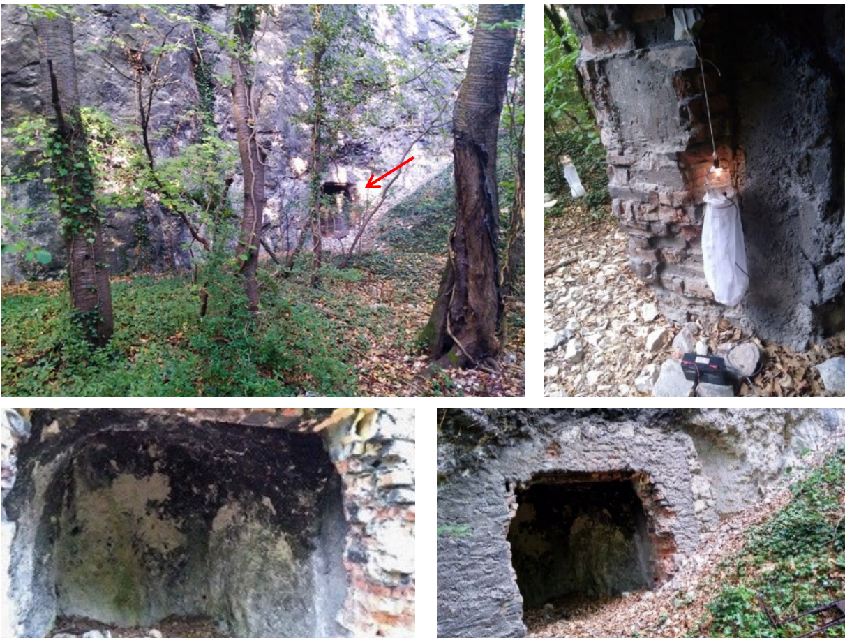
Abb. 22: Zugemauerter Tunnel am „Isteiner Klotz“ mit und ohne Lichtfalle.
