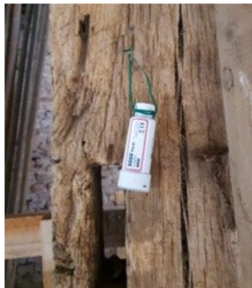
Abb. 15: Hobo Pro v2-Datenlogger fixiert innerhalb der Scheune eines Standortes.
