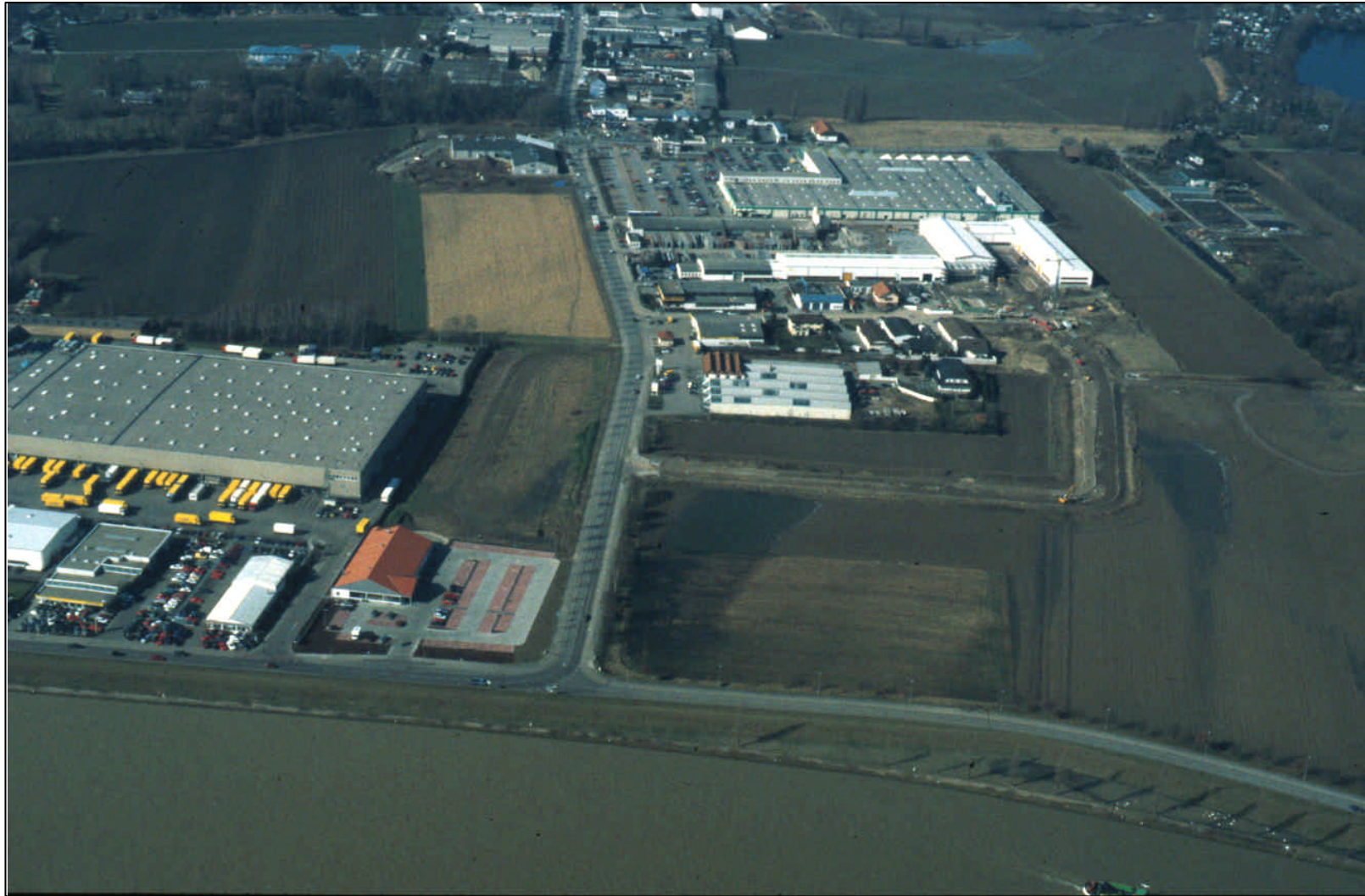
Abb. 127.: Ehemalige Hasenpfuhler Weide im Norden von Speyer im Februar 1999. Neben den erst vor wenigen Jahren errichteten Gewerbeflächen (z.B. links im Bild Großlager der Firma „Lidl“) sind deutlich großflächige Druckwasseraustritte zu sehen. Quelle: Eigenes Foto
